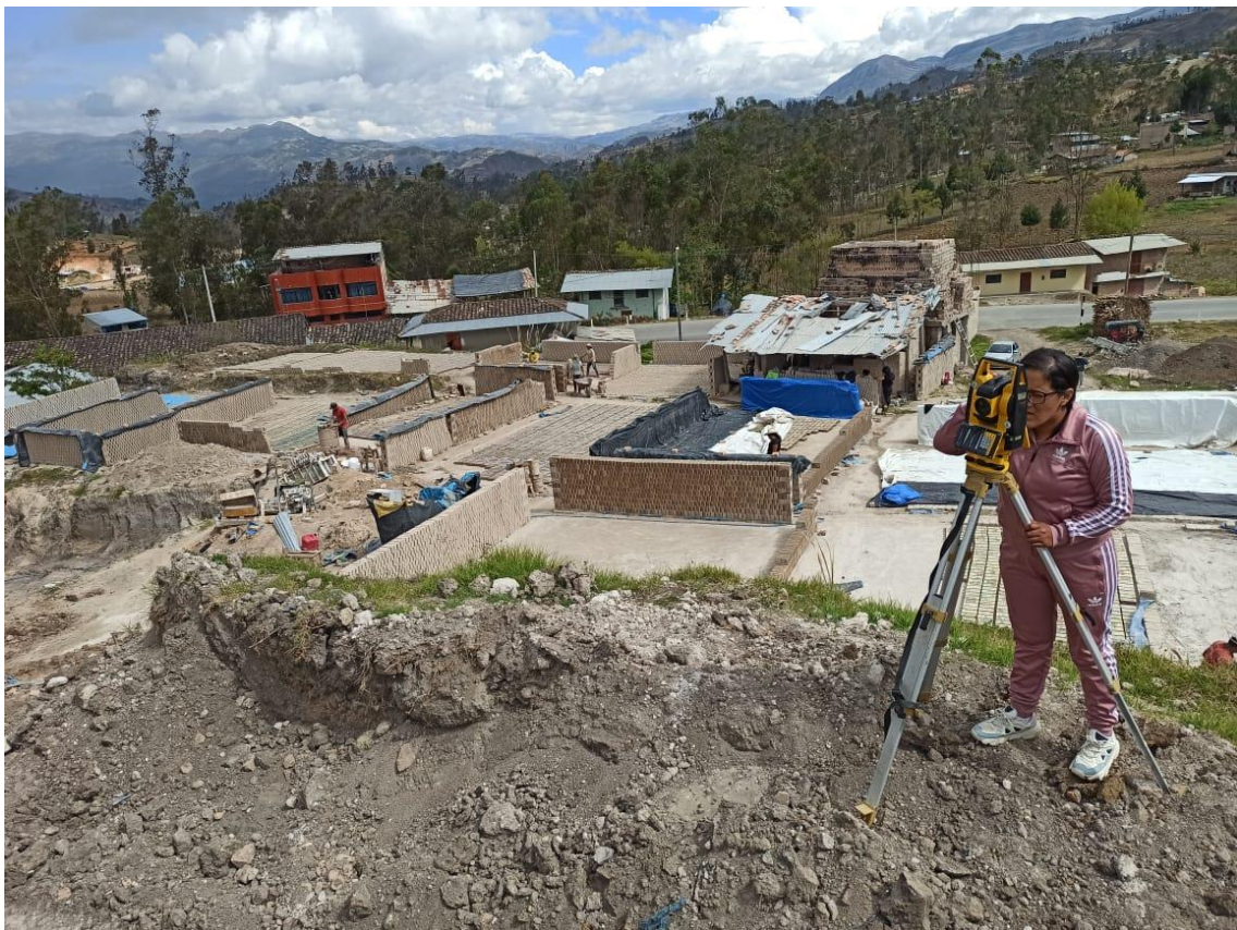
Fotografía 4. Levantamiento topográfico en la cantera La Lucma San Rafael
