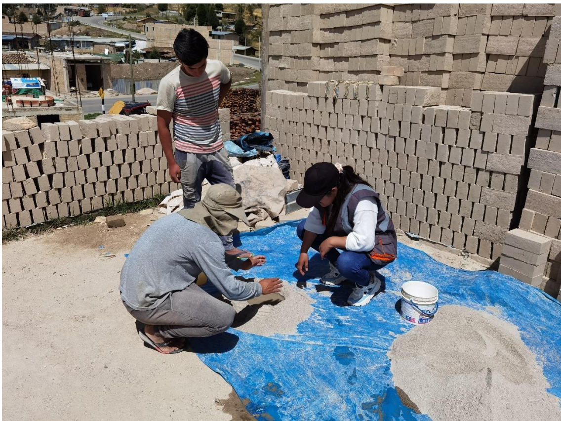
Fotografía 16. Mezcla de las proporciones de suelo
