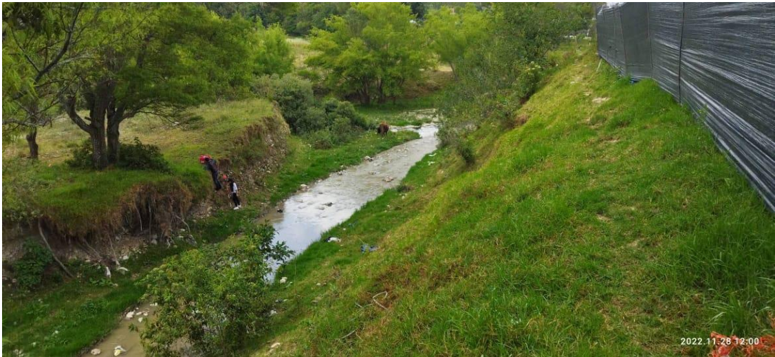
Fotografía 14 Levantamiento topográfico del cauce del río chotano 150 m aguas abajo.
