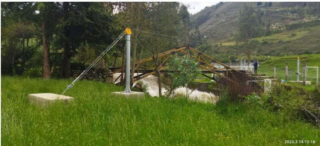
Fotografía 29 Torre y cámara de anclaje de la Estación Hidrología Chonta.
