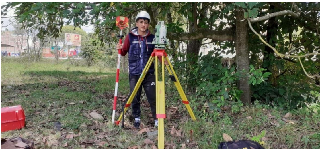
Fotografía 6 Levantamiento topográfico coordenada y altitud del BM-03.
