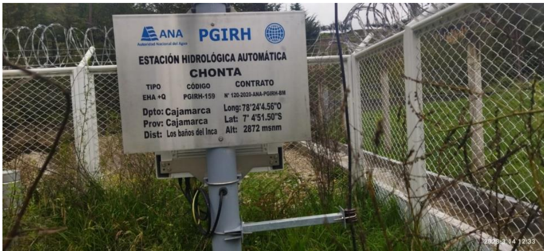
Fotografía 22 Estación Hidrológica Automática y Sistema Mecanizado de Aforos Chonta – distritos de Baños del Inca y la Encañada - región Cajamarca.
