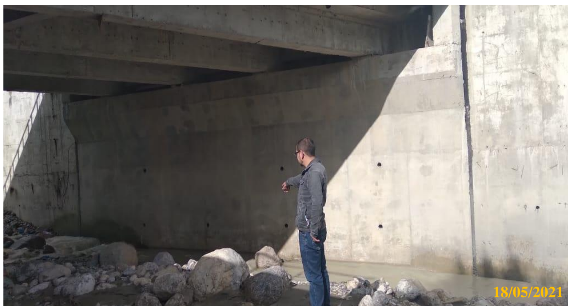
Fotografía 4. Vista de acumulación de sedimentos en la base del puente Colpamayo ubicado en el Jr. Sagrado Corazón de Jesús
