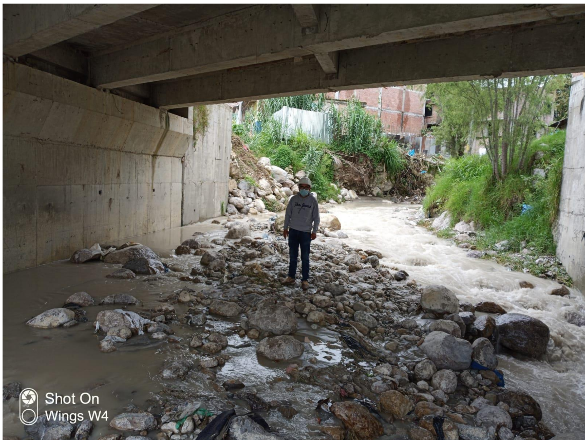
Fotografía 6. Puente Colpamayo en la quebrada La Potrera
