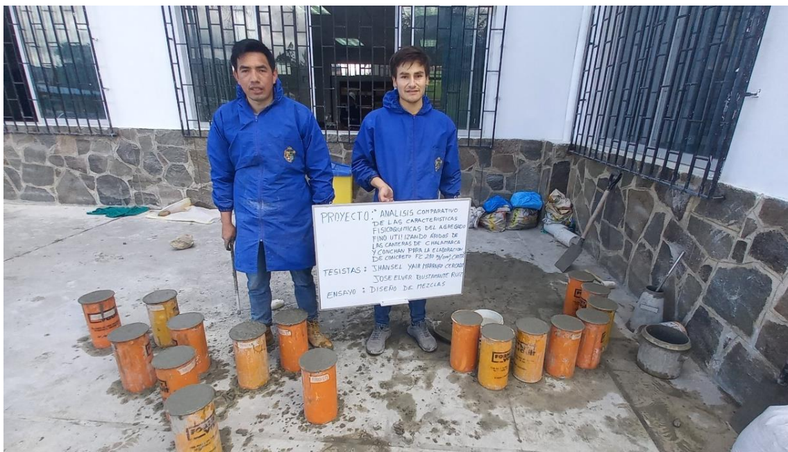
Fotografía 34 Preparación de Mezcla para Elaboración de Probetas de Concreto
