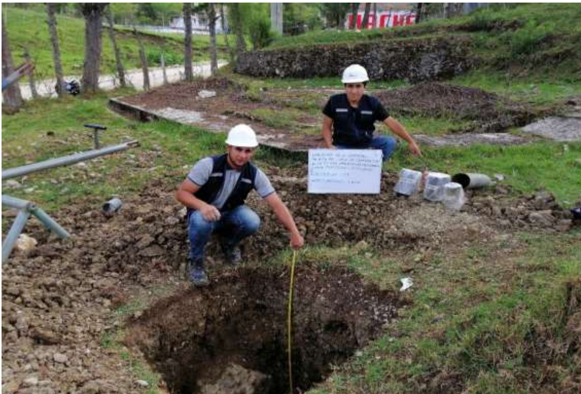
Figura 25 Excavación de Calicatas de 3 m. de profundidad en la I.E. 10392 – Cabracancha
