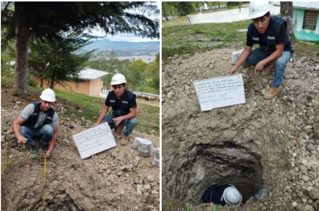
Fotografía 8. Excavación de la calicata 4 (3 m. de profundidad) en la I.E. Cabracancha
