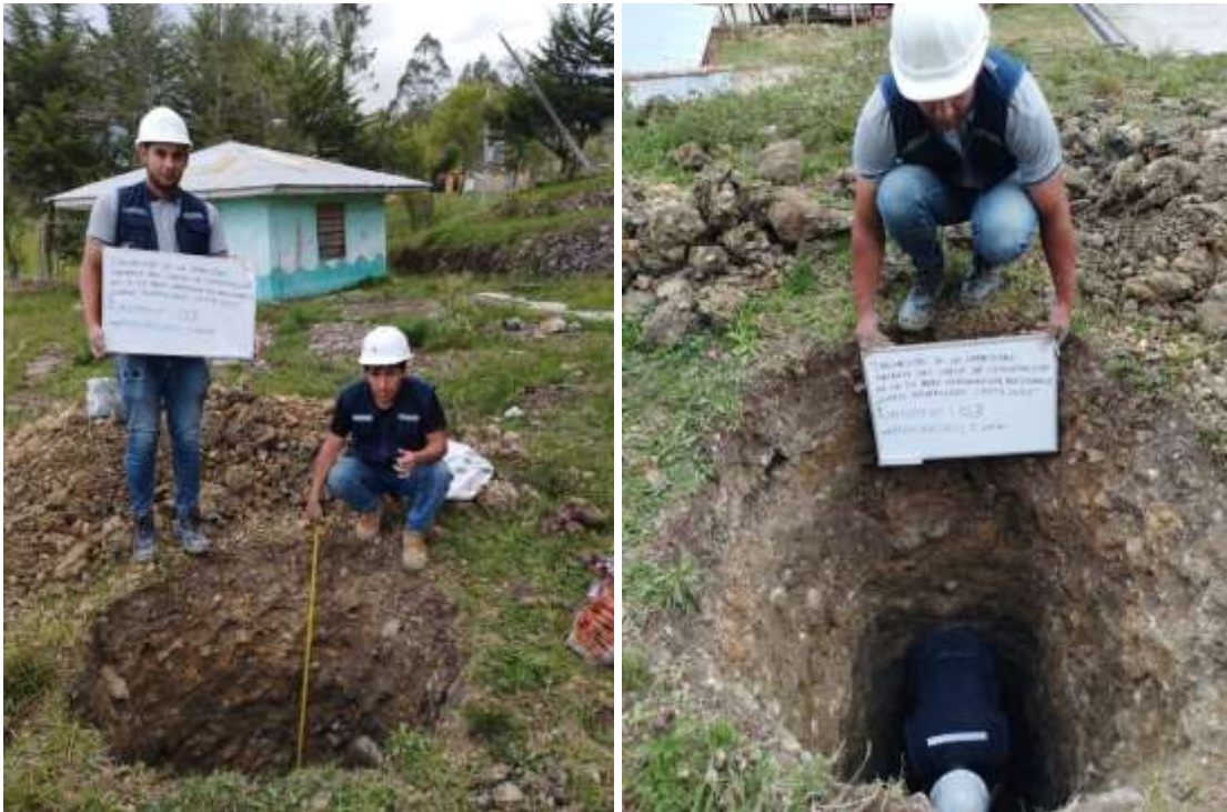
Fotografía 7. Excavación de la calicata 3 (3 m. de profundidad) en la I.E. Cabracancha
