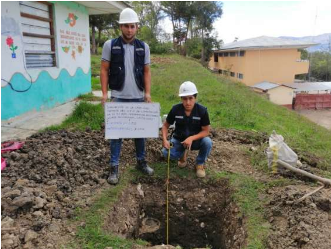
Fotografía 6. Excavación de la calicata 2 (3 m. de profundidad) en la I.E. Cabracancha
