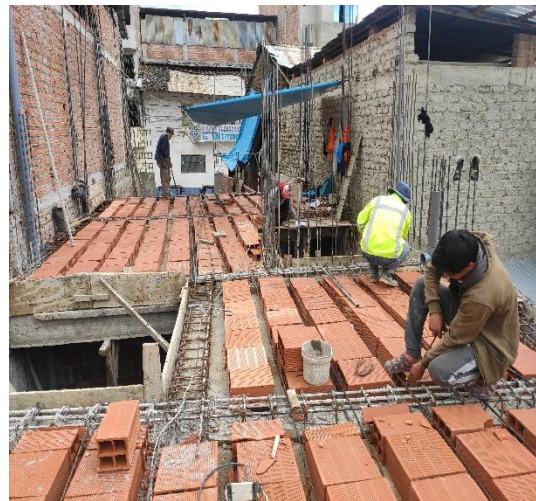
Fotografía 18. Vaciado d/losa aligerada 3
