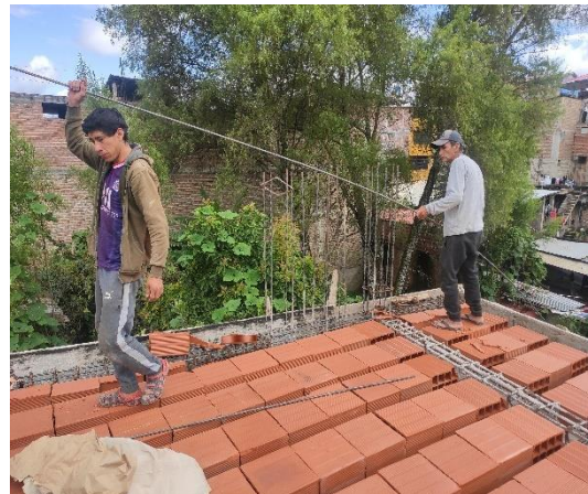
Fotografía 82. Habilitación d/acero Viv.14
