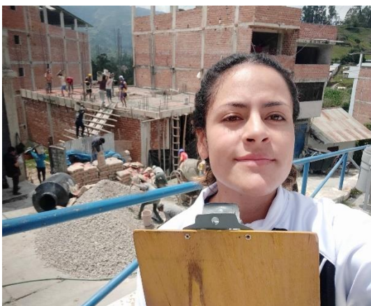
Fotografía 35. Vaciado d/losa aligerada 6
