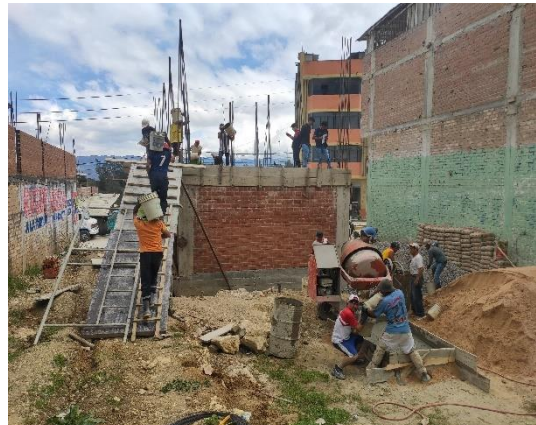
Fotografía 72. Vaciado d/losa aligerada 12
