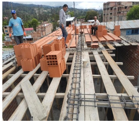
Fotografía 66. Vaciado d/losa aligerada 11
