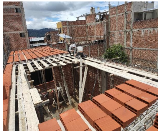
Fotografía 48. Vaciado d/losa aligerada 8
