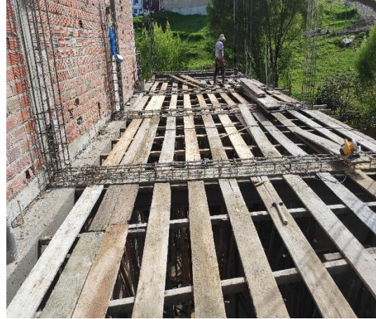
Fotografía 4. Vaciado d/losa aligerada 1
