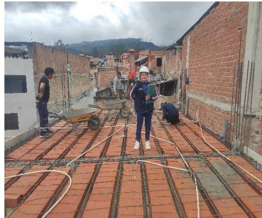
Fotografía 48. Vaciado d/losa aligerada 8
