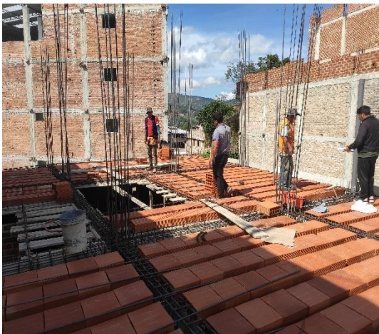
Fotografía 35. Vaciado d/losa aligerada 6
