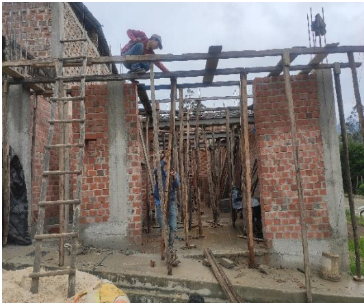
Fotografía 57. Encofrado en Vivienda 10
