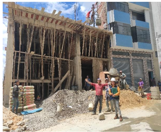
Fotografía 54. Vaciado d/losa aligerada 9
