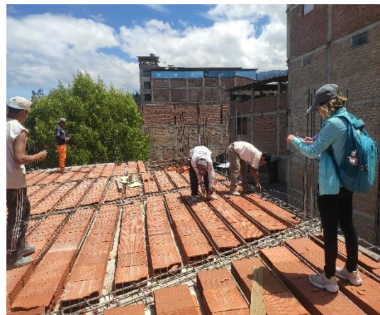
Fotografía 30. Vaciado d/losa aligerada 5
