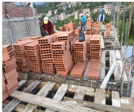
Fotografía 78. Vaciado d/losa aligerada 13
