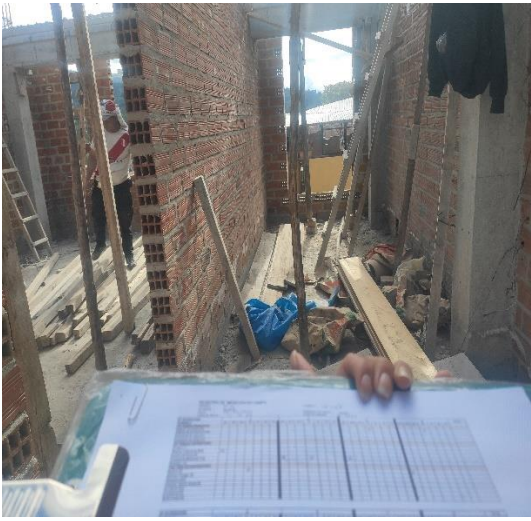
Fotografía 63. Colocación d/ladrillo viv.11
