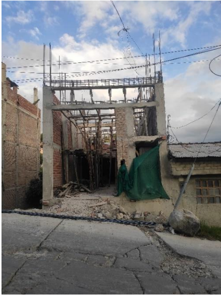
Fotografía 75. Encofrado en Vivienda 13
