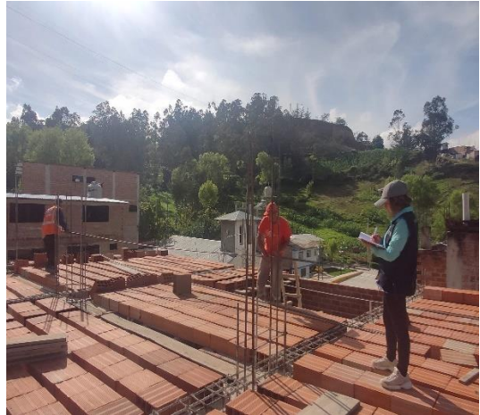
Fotografía 42. Vaciado d/losa aligerada 7
