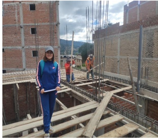
Fotografía 32. Encofrado en la Vivienda 6
