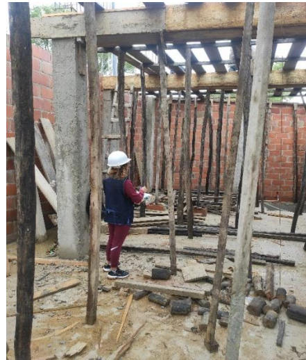
Fotografía 80. Encofrado en Vivienda 14
