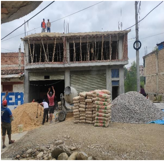
Fotografía 39. Colocación d/ladrillo Viv7
