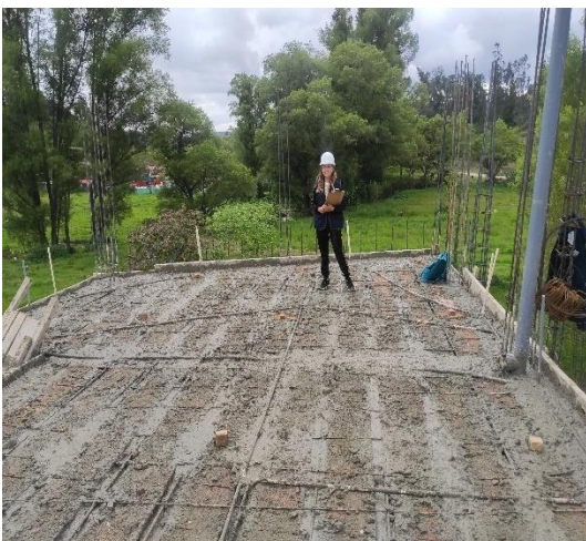
Fotografía 11. Vaciado d/losa aligerada 2
