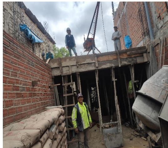
Fotografía 18. Vaciado d/losa aligerada 3
