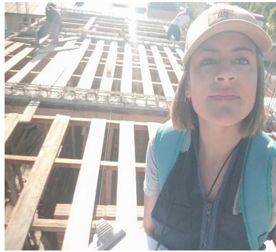
Fotografía 62. Encofrado en la Vivienda 11
