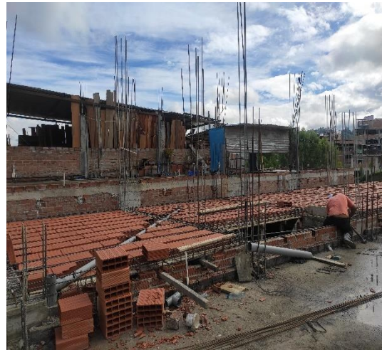
Fotografía 24. Vaciado d/losa aligerada 4
