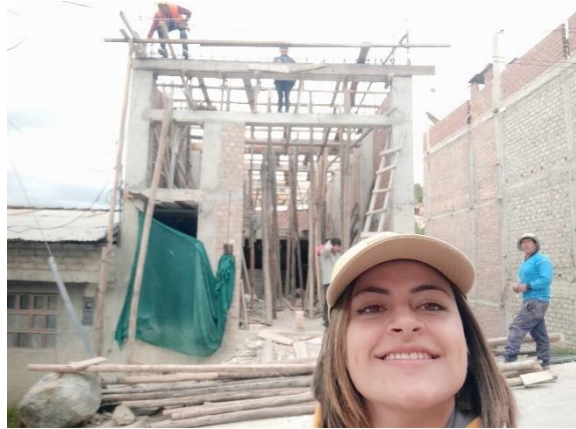
Fotografía 74. Encofrado en la Vivienda 13
