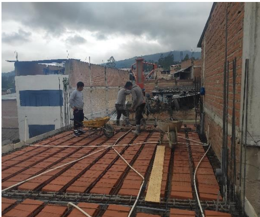
Fotografía 47. Vaciado d/losa aligerada 8
