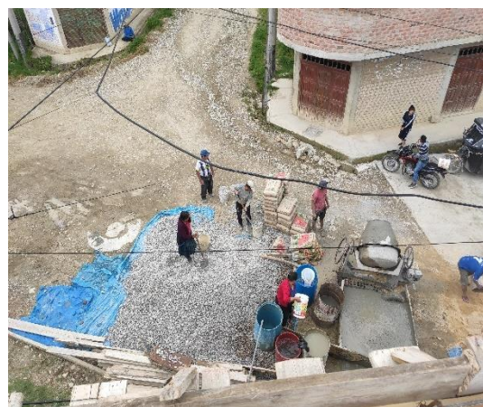
Fotografía 90. Vaciado d/losa aligerada 15
