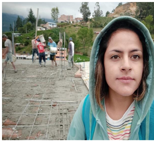
Fotografía 42. Vaciado d/losa aligerada 7
