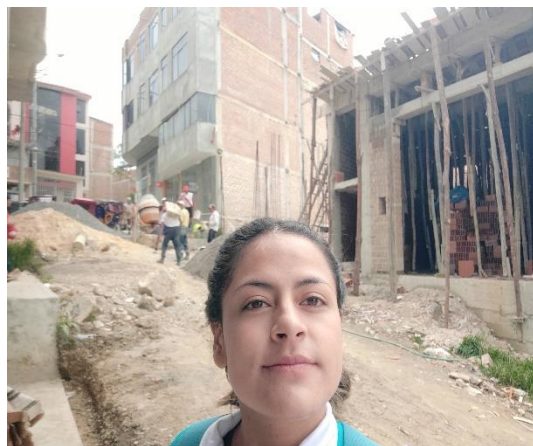
Fotografía 84. Vaciado d/losa aligerada 14
