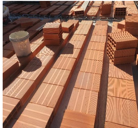
Fotografía 72. Vaciado d/losa aligerada 12
