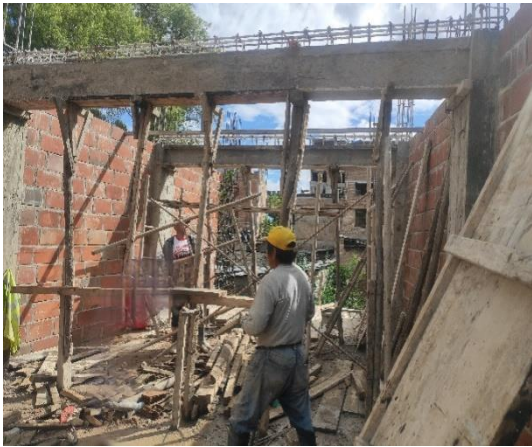
Fotografía 87. Colocación d/ladrillo viv.15
