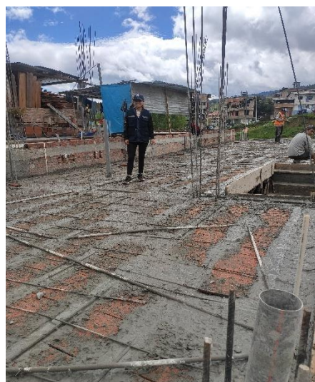
Fotografía 24. Vaciado d/losa aligerada 4
