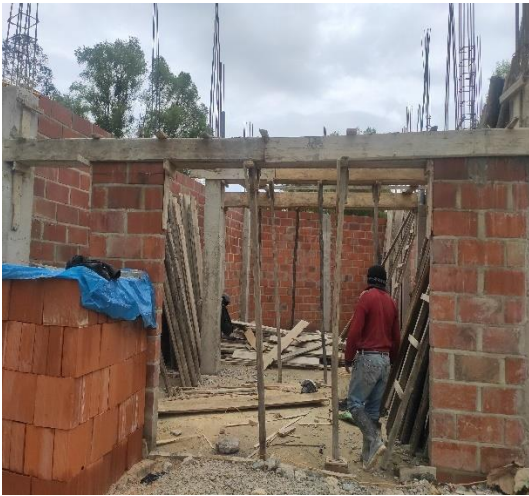
Fotografía 9. Colocación de ladrillo Viv.2
