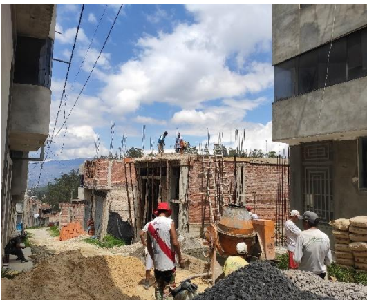
Fotografía 29. Vaciado d/losa aligerada 5
