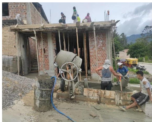
Fotografía 60. Vaciado d/losa aligerada 10
