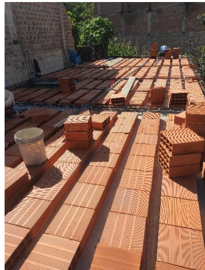
Fotografía 60. Vaciado d/losa aligerada 10
