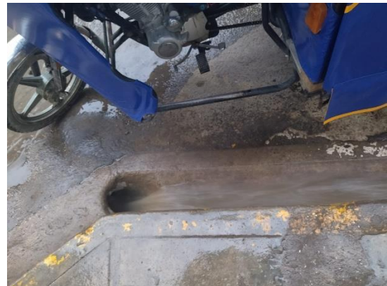
FOTO N° 30: SUMIDEROS EN LAS CALLES NO APTAS PARA LA ZONA DE LLUVIAS FUERTES.
