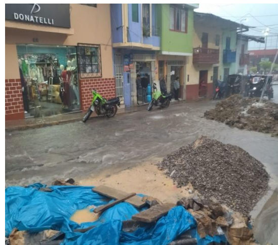
FOTO N° 41: INTERRUPCIONES EN LAS VIAS PRODUCEN QUE LAS AGUAS DE ESCURRIMIENTO COLAPSEN.
