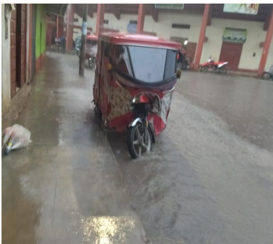
FOTO N° 38: PRODUCTO DE UN INADECUADO SISTEMA DE DRENAJE LAS ESTRUCTURAS COLAPSAN EN ÉPOCAS DE LLUVIAS.
