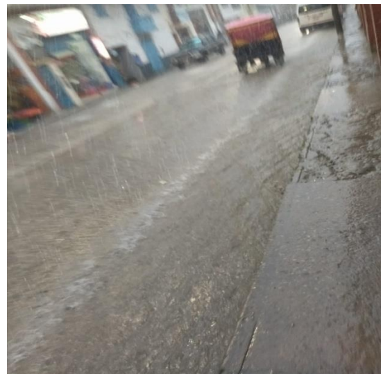
FOTO N° 35: EN ÉPOCAS DE LLUVIA SE PRODUCEN INUNDACIONES POR LA FALTA DE OPTIMAS CONDICIONES DE DRENAJE PLUVIAL
