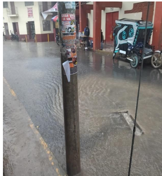
FOTO N° 36: EN ÉPOCAS DE LLUVIA SE PRODUCEN INUNDACIONES POR LA FALTA DE OPTIMAS CONDICIONES DE DRENAJE PLUVIAL
