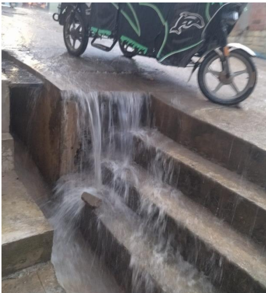
FOTO N° 33: POR FALTA DE CUNETAS OPTIMAS LAS AGUAS COLAPSAN Y ESCURREN POR LAS CALLES.
