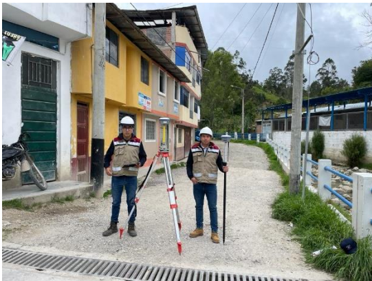
FOTO N° 02: LEVANTAMIENTO TOPOGRÁFICO CON GPS DIFERENCIAL.
