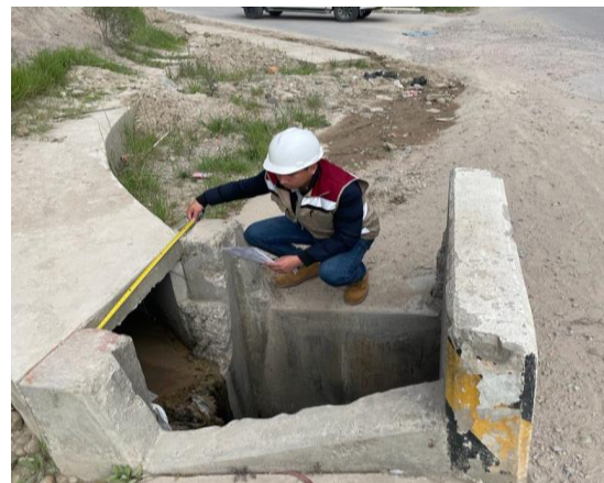
FOTO N° 24: INSPECCIÓN OCULAR DE LAS ALCANTARILLAS.
