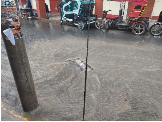
FOTO N° 37: PRODUCTO DE UN INADECUADO SISTEMA DE DRENAJE LAS ESTRUCTURAS COLAPSAN EN ÉPOCAS DE LLUVIAS.
