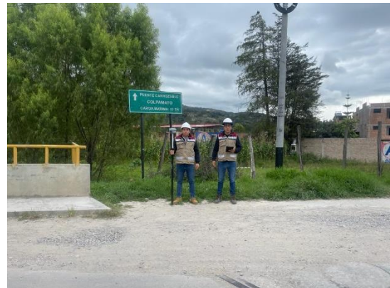
FOTO N° 06: L.T EN EL PUENTE COLPAMAYO (QUEBRADA COLPAMAYO)
