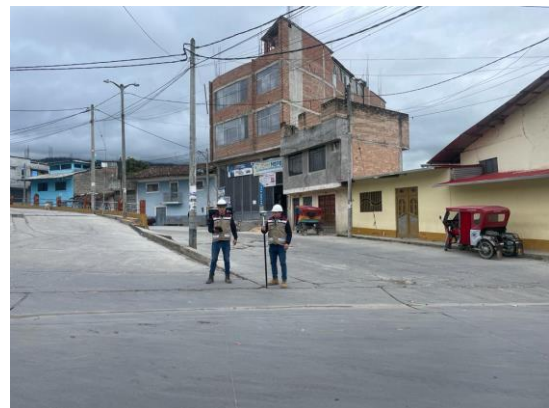
FOTO N° 11: L.T AV. INCA GARCILAZO DE LA VEGA (PARQUE EL RONDERO)
