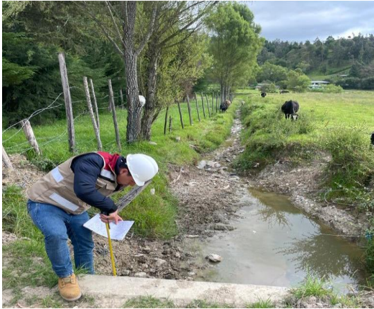
FOTO N° 25: VERIFICACIÓN DE ALCANTARILLAS EVACUACIÓN DE AGUAS.
