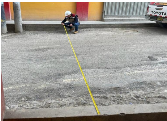
FOTO N° 21: VERIFICACIÓN DE CALZADAS DEL SECTOR 2.
