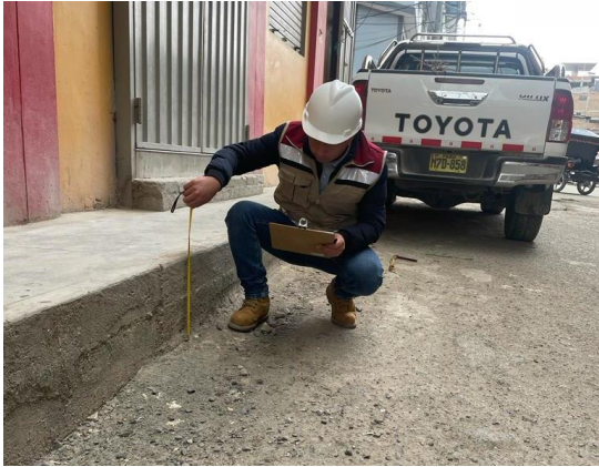
FOTO N° 19: FALTA DE CUNETAS EN LAS CALLES.
