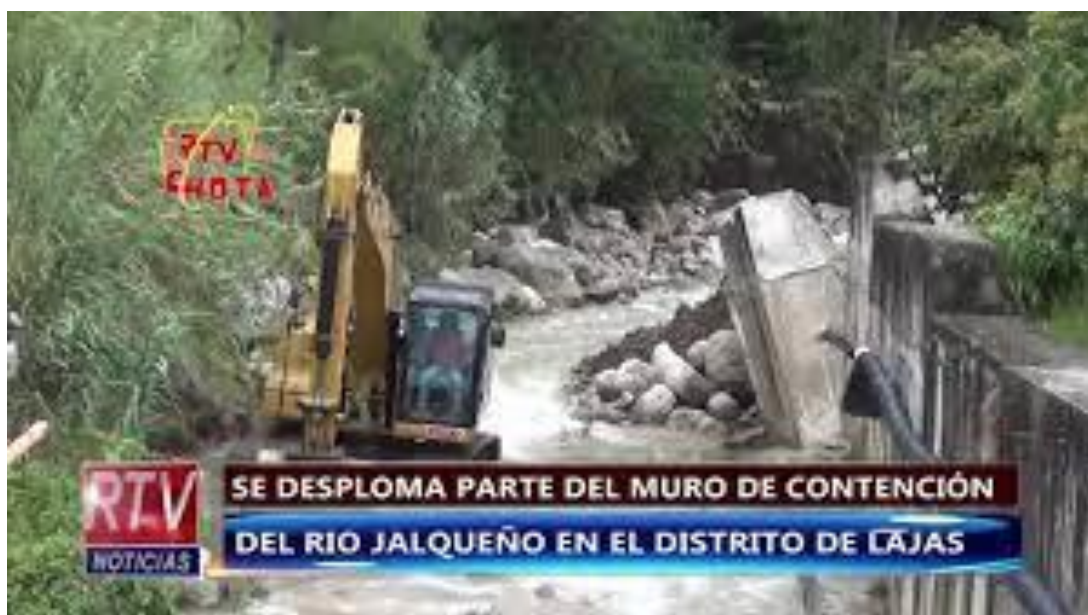
Fotografía 4. Desplome del muro de contención a causa del aumento del caudal del río Jalqueño
