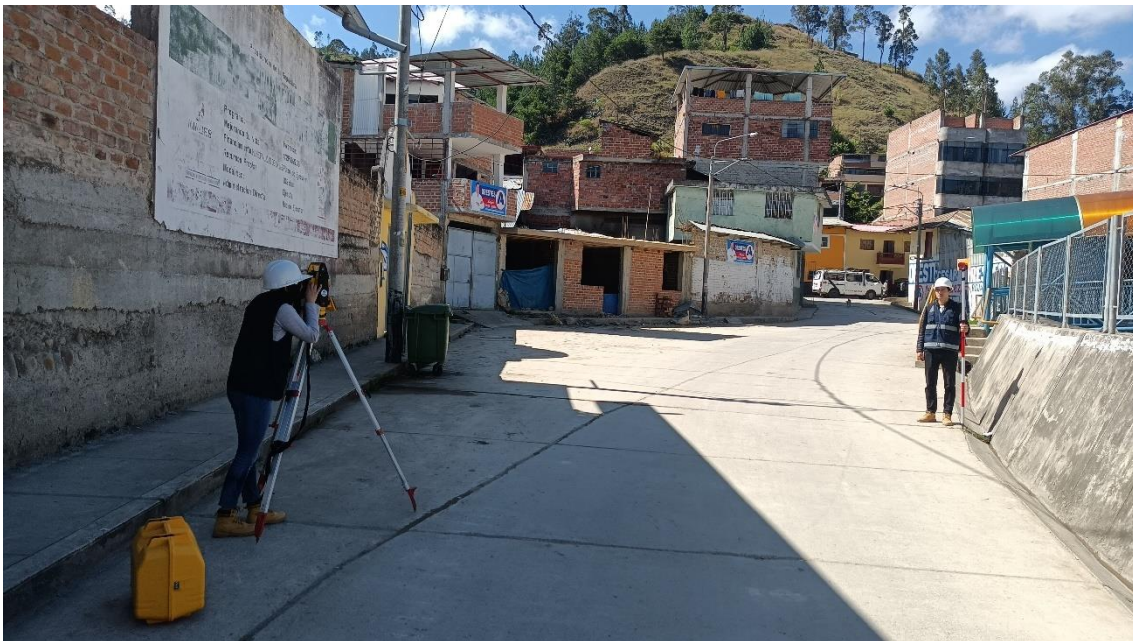
Fotografía 13. Levantamiento topográfico a 50 m del borde del río Jalqueño en el margen izquierdo del tramo inicial de 0+000 km a 0+500
