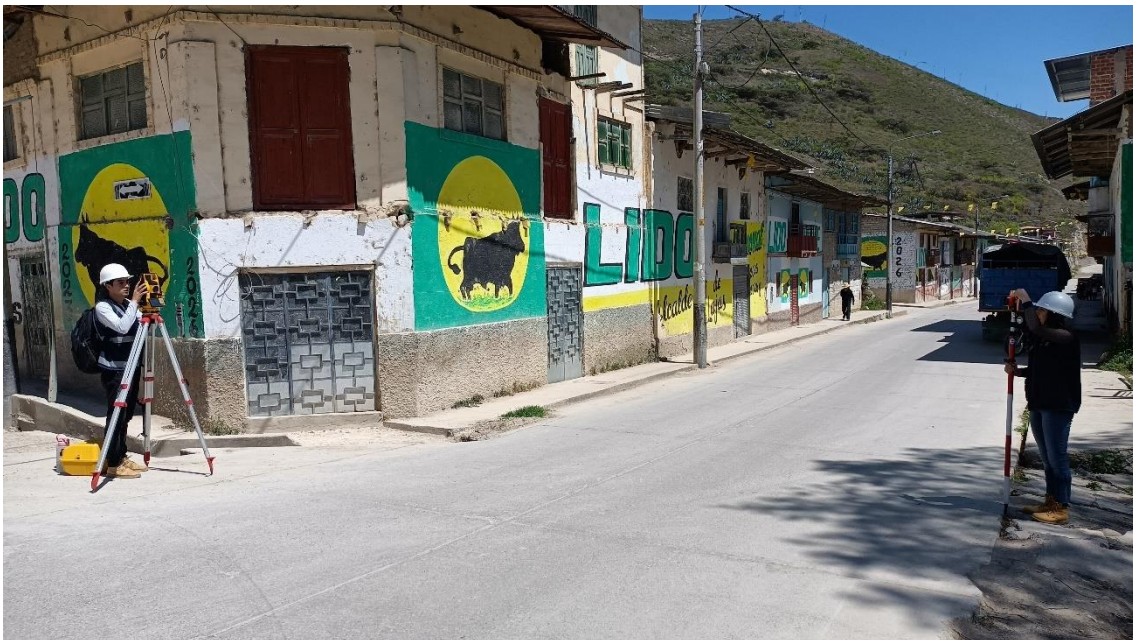
Fotografía 14. Levantamiento topográfico a 50 m del borde del río Jalqueño en las calles y edificaciones aledañas al cauce
