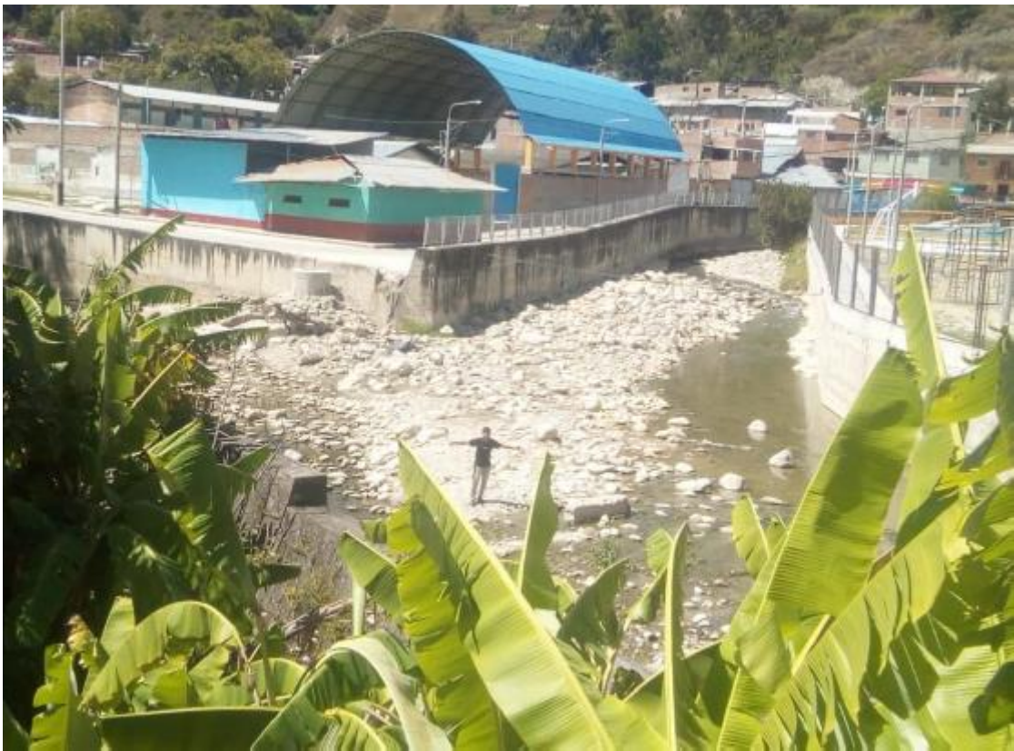
Fotografía 10. Vista del tramo inicial de Km 0+000 al Km 0+200 del río Jalqueño donde hay muros de contención en el margen derecho e izquierdo
