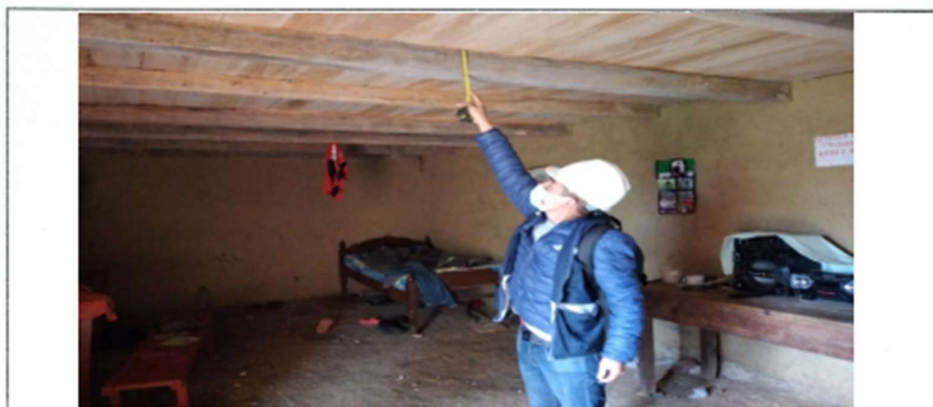
Fotografía 02. Registro de medidas de la viga macizas
