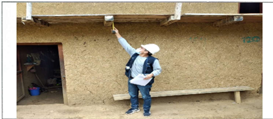
Fotografía 02. Registro de medidas de la viga macizas
