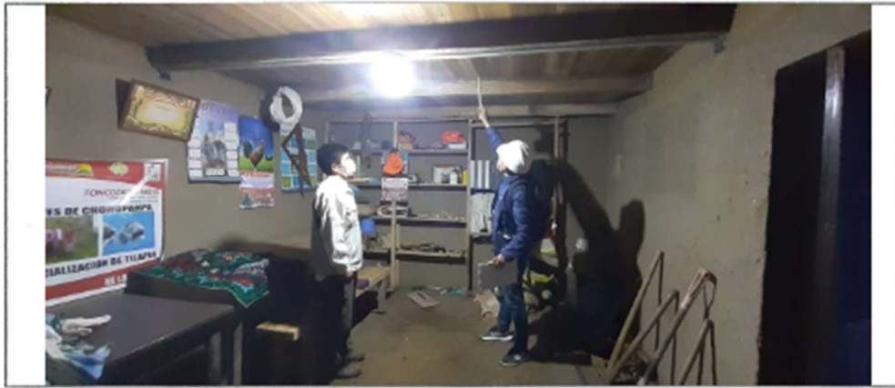
Fotografía 02. Registro de medidas de la viga macizas
