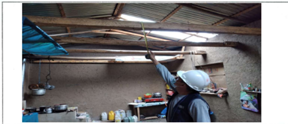
Fotografía 02. Registro de medidas de la viga macizas
