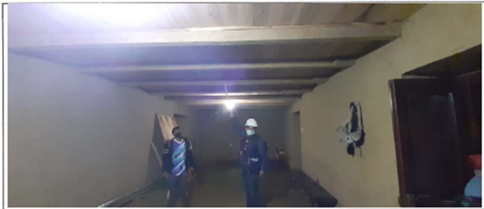
Fotografía 02. Registro de medidas de la viga macizas
