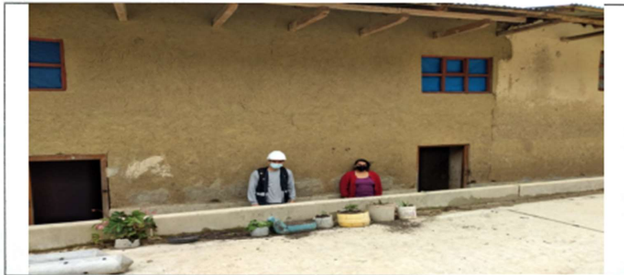
Fotografía 01. Vivienda construida con vigas macizas de madera Clethra obovata
