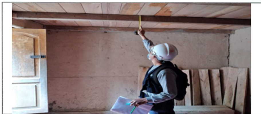
Fotografía 02. Registro de medidas de la viga macizas
