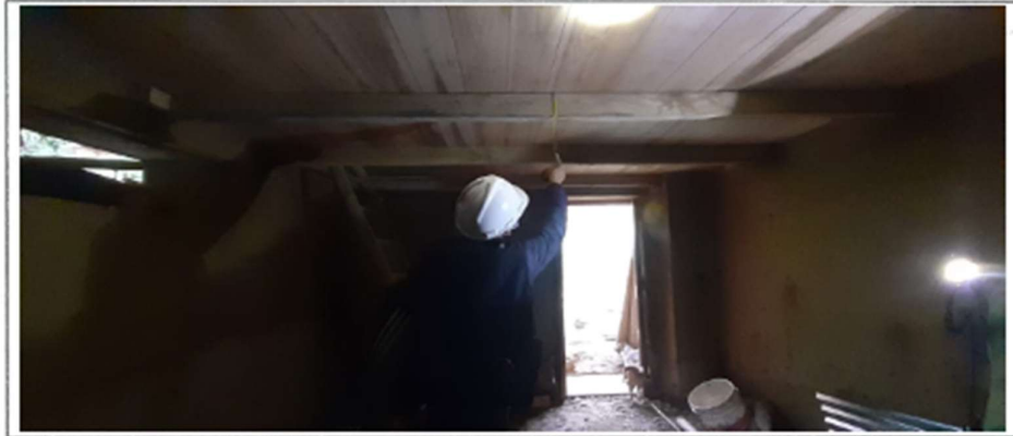
Fotografía 02. Registro de medidas de la viga macizas
