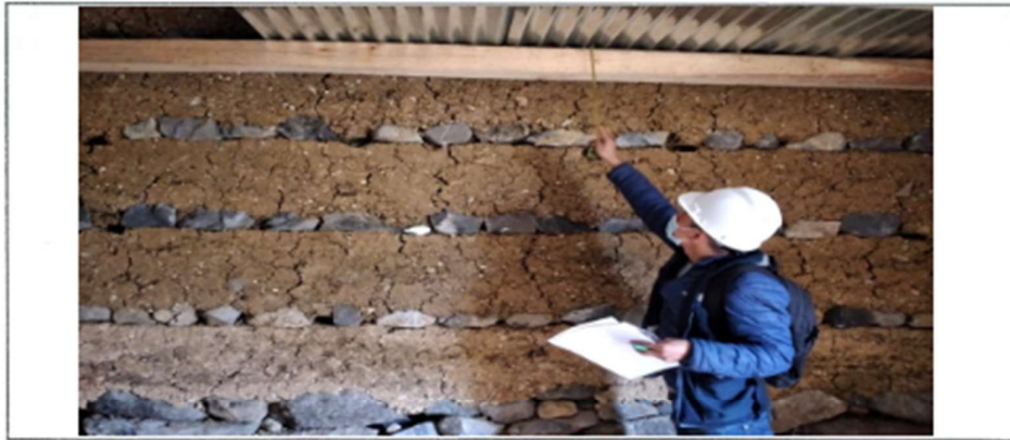
Fotografía 02. Registro de medidas de la viga macizas
