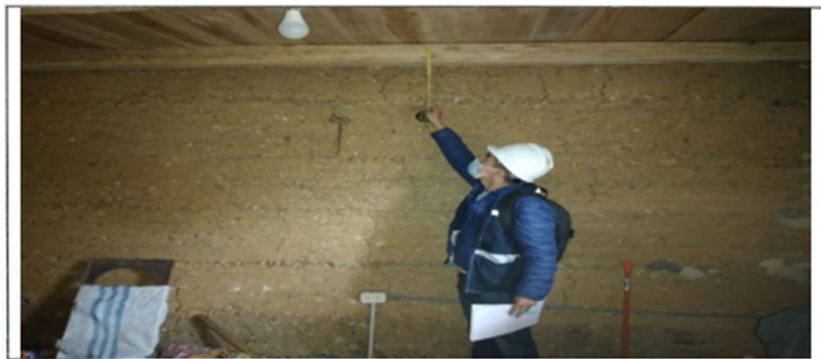
Fotografía 02. Registro de medidas de la viga macizas
