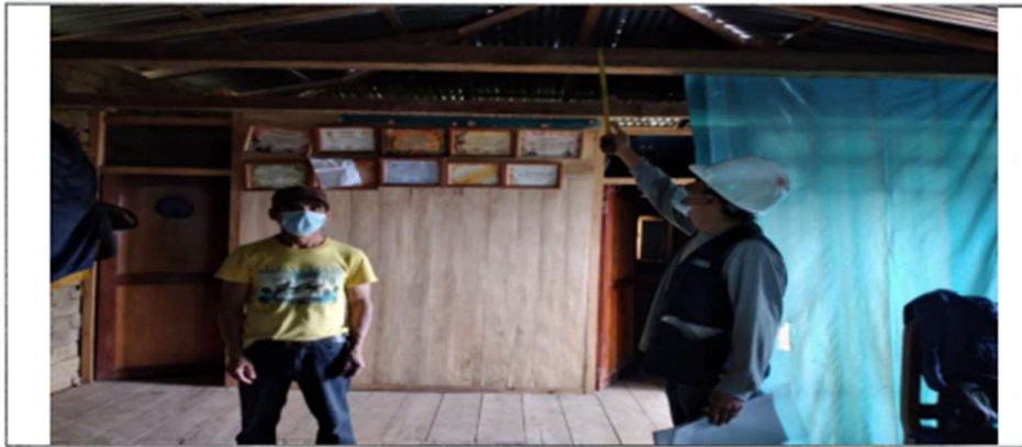
Fotografía 02. Registro de medidas de la viga macizas
