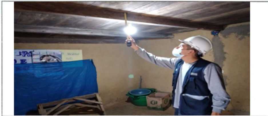
Fotografía 02. Registro de medidas de la viga macizas
