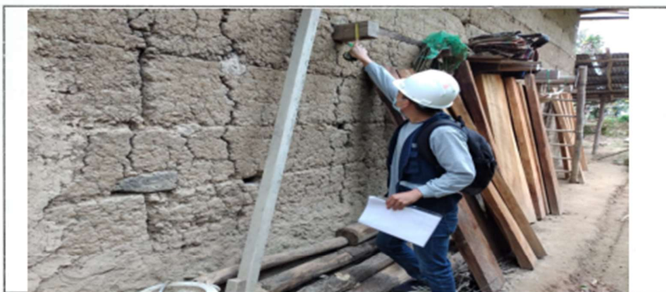
Fotografía 02. Registro de medidas de la viga macizas
