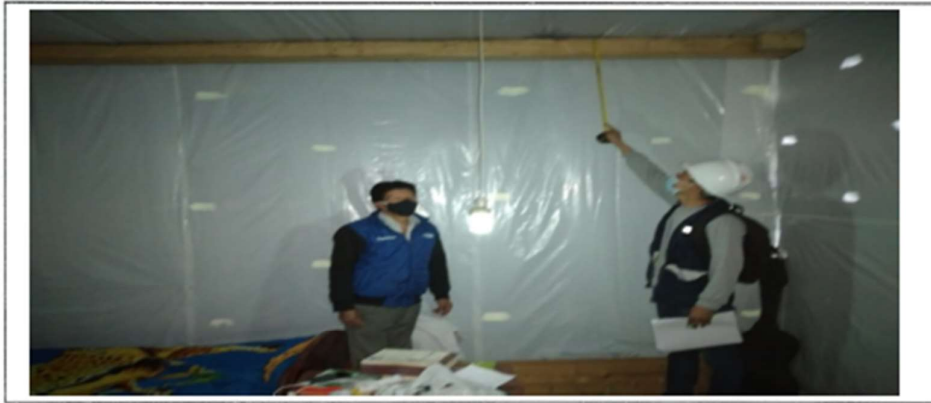
Fotografía 02. Registro de medidas de la viga macizas
