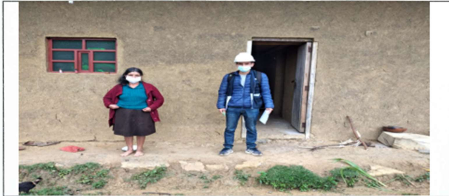
Fotografía 01. Vivienda construida con vigas macizas de madera Clethra obovata
