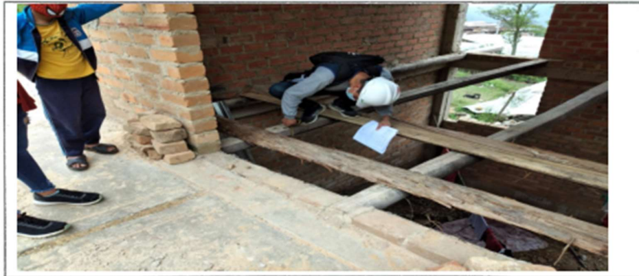
Fotografía 02. Registro de medidas de la viga macizas
