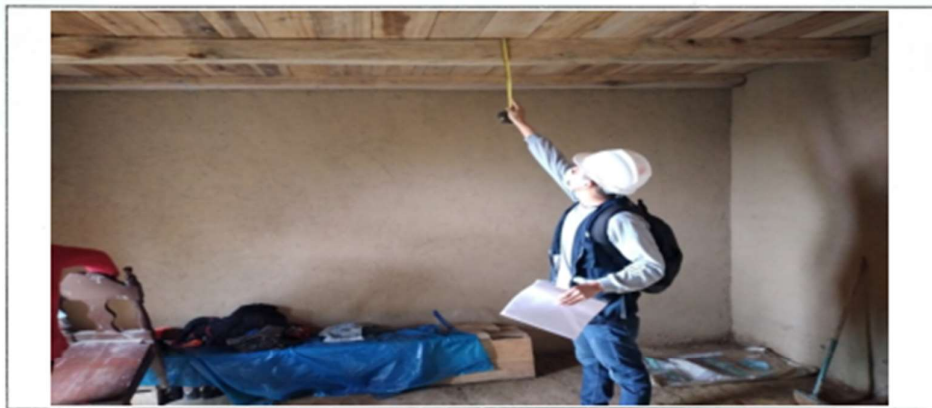
Fotografía 02. Registro de medidas de la viga macizas
