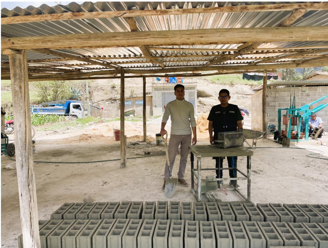
Fotografía 11. Secado de los Bloques
