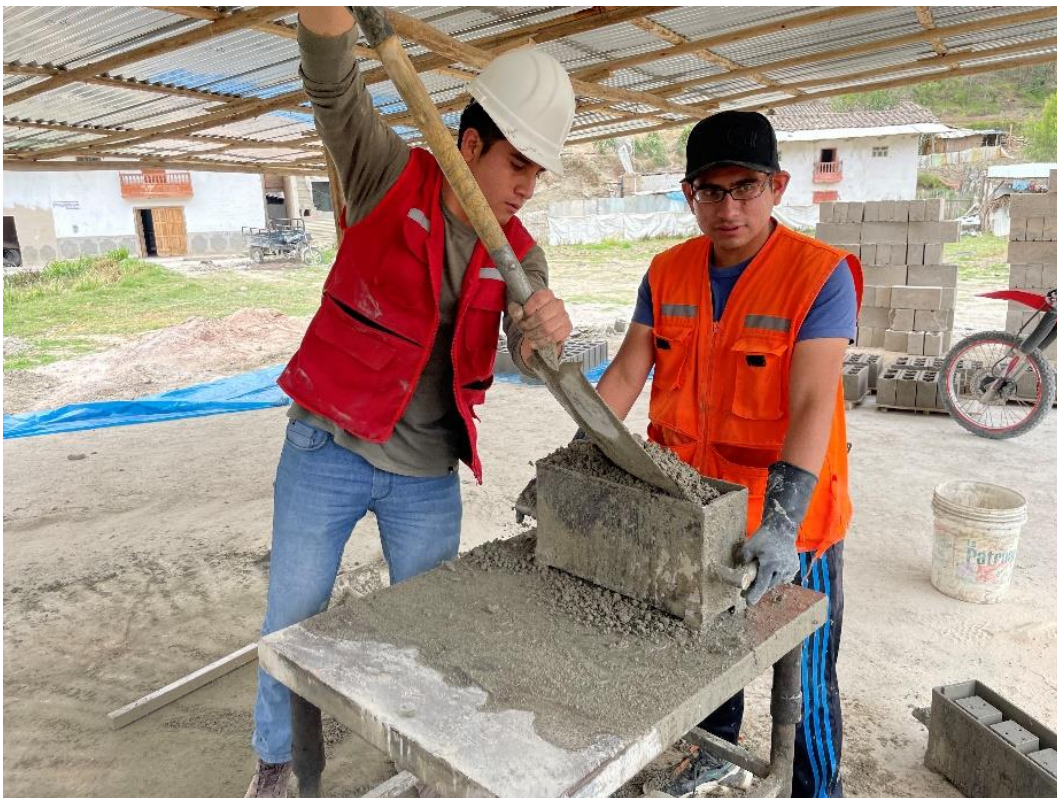
Fotografía 10. Procedimiento de Moldeado y Vibrado
