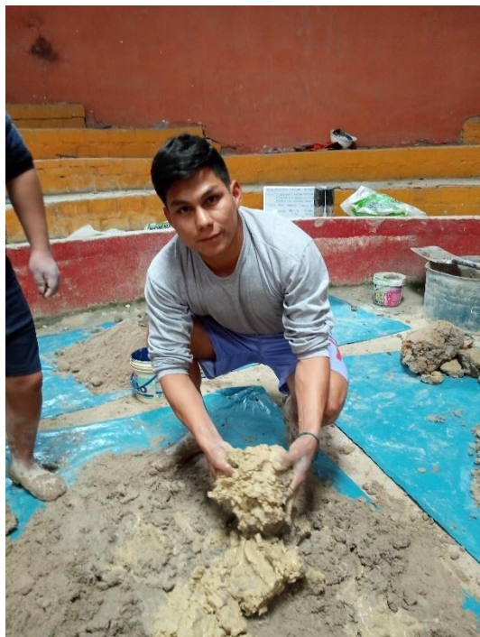
Colocación de la mezcla en el adobe
