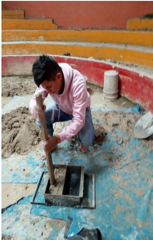
Compactación del suelo en capas
