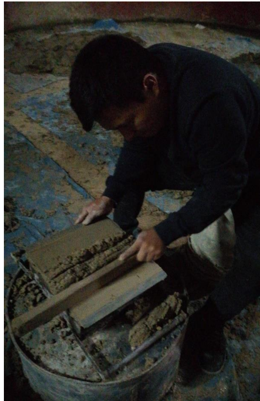
Proceso de retiro material sobrante
