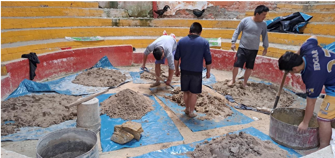
Fotografía 14 Preparación de área de trabajo para la producción de adobes
