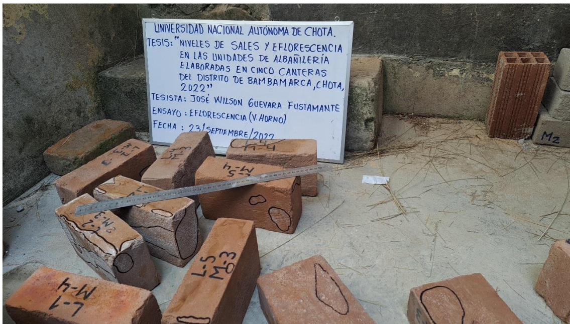
Fotografía 21. Ladrillos con eflorescencia de velo de horno
