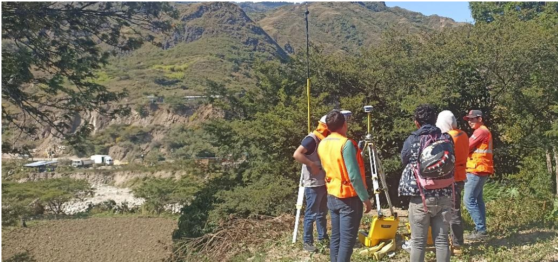
Fotografía 4. Toma de puntos en el eje de la Quebrada Lancheconga-Yamaluc
