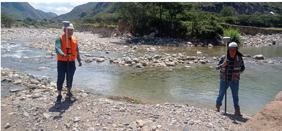
Fotografía 5. Toma de puntos en los bordes de la Quebrada Lancheconga-Yamaluc
