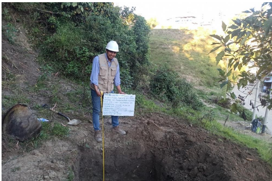
Figura 52 Vista de la calicata 6
