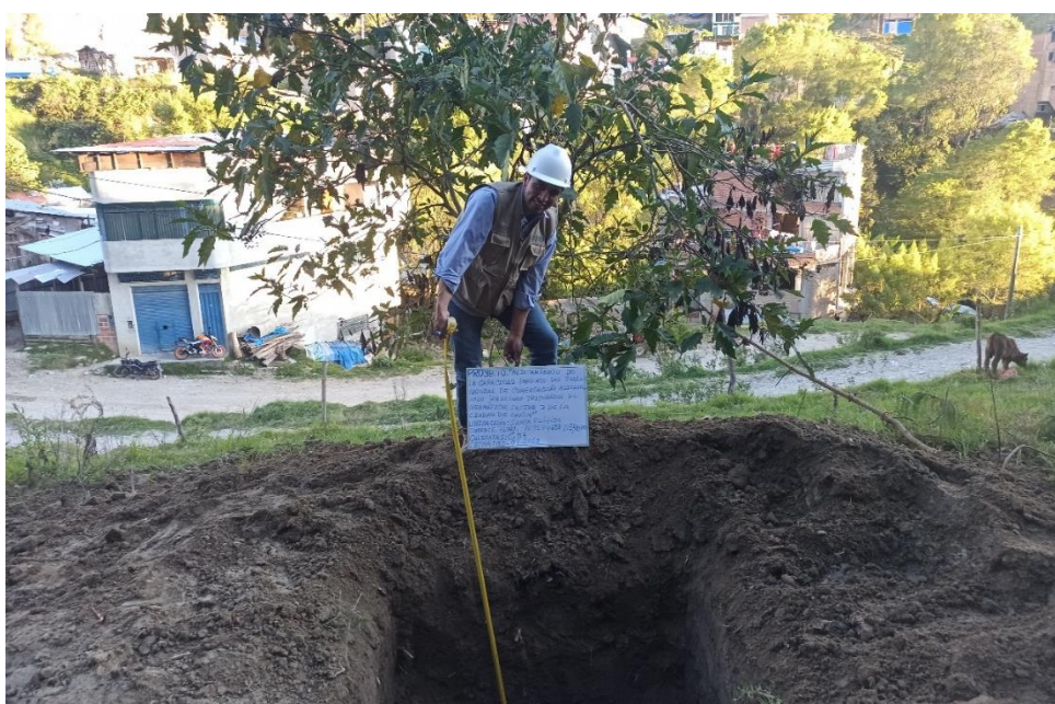
Figura 53 Vista de la calicata 7
