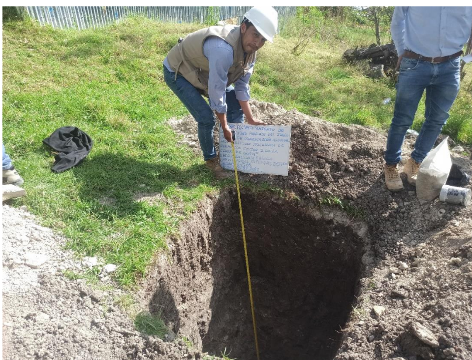
Figura 45 Altura de la calicata 2
