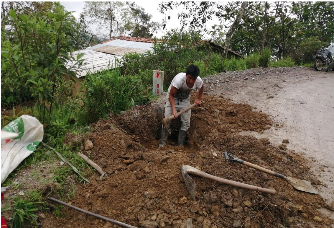
Fotografía 5. Excavación de las calicatas
