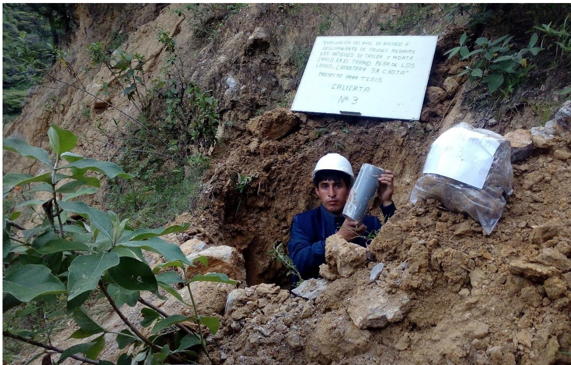
Fotografía 6. Calicata 3, en el talud Peña de los Loros
