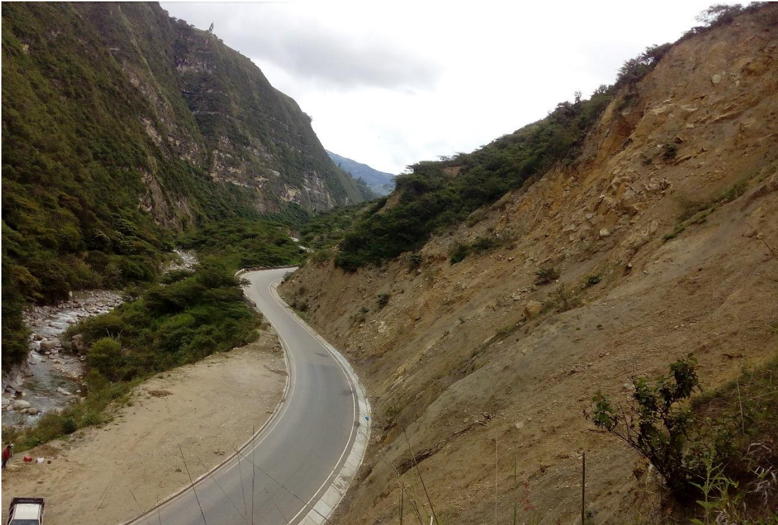
Fotografía 1. Vista del talud Peña de los Loros
