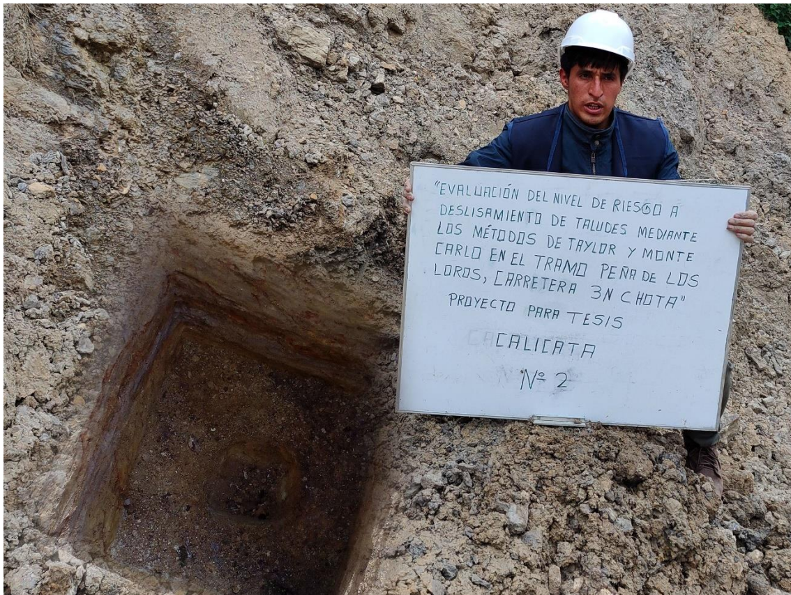
Fotografía 5. Calicata 2, en el talud Peña de los Loros
