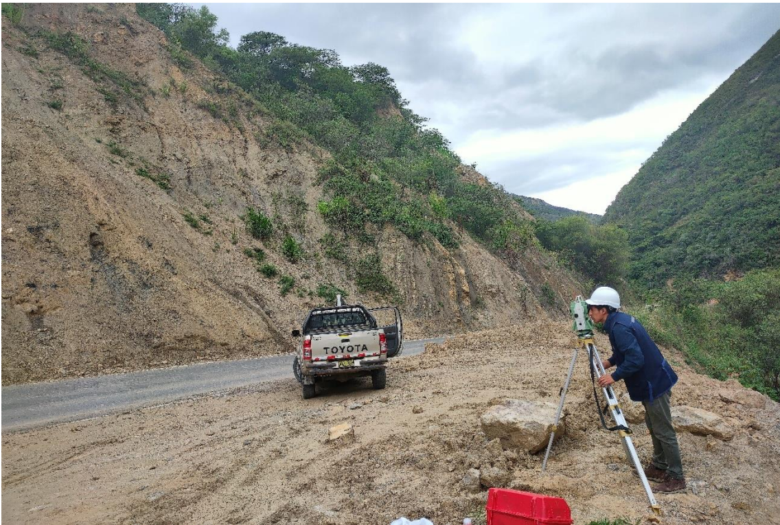
Fotografía 2. Realización del levantamiento topográfico en la Peña de los Loros
