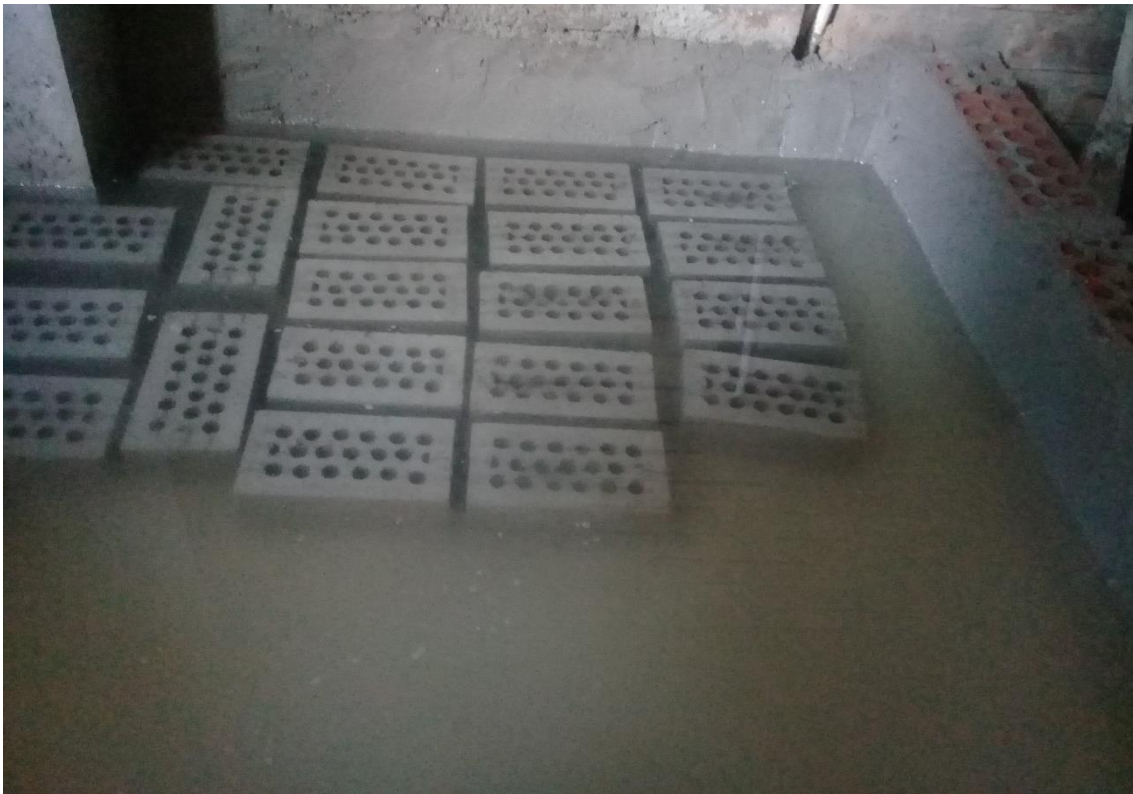
Fotografía 17. Curado de unidades de albañilería
