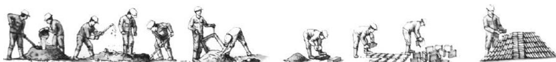
Se obtiene una pasta plástica, se amasa y se deja reposar por 3 a 4 días. La tierra se coloca en un molde rectangular que se rellena sin compresión, se enrasa y se desmolda. Se colocan en filas cada 1 m con espacio para poder caminar entre ellas. El proceso de secado natural al sol. Entre una o dos semanas boca-arriba, después se colocan de costado 5-10 días más.
