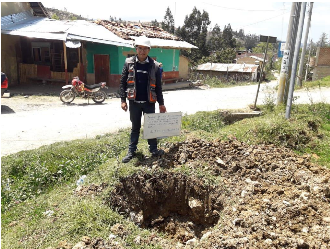
Figura 8. Muestreo de Suelos Calicata 4 Ruta 1 Chota – Campamento
