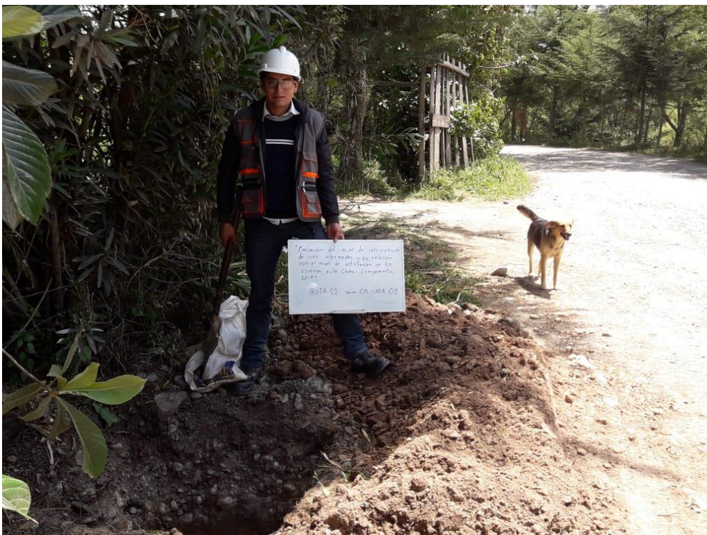
Figura 6. Muestreo de Suelos Calicata 2 Ruta 1 Chota – Campamento
