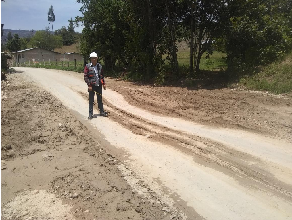
Figura 25. Presencia de Falla por Deformación en la Ruta 2
