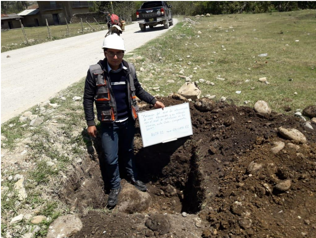
Figura 5. Muestreo de Suelos Calicata 1 Ruta 1 Chota – Campamento
