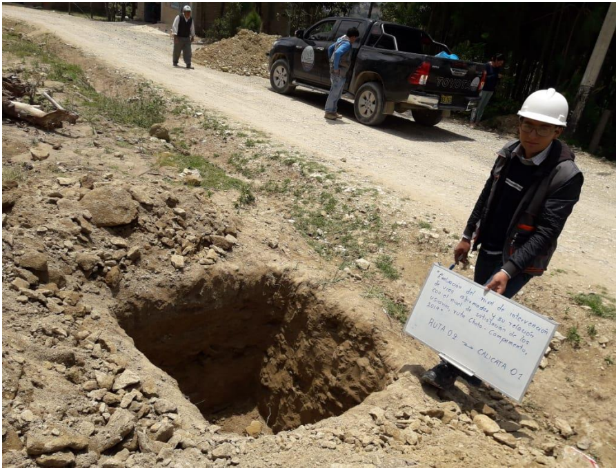
Figura 9. Muestreo de Suelos Calicata 1 Ruta 2 Chota – Campamento
