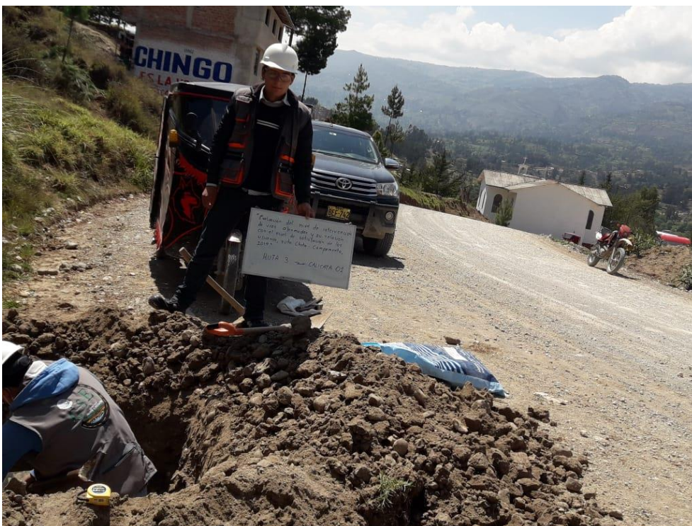
Figura 12. Muestreo de Suelos Calicata 1 Ruta 3 Chota – Campamento
