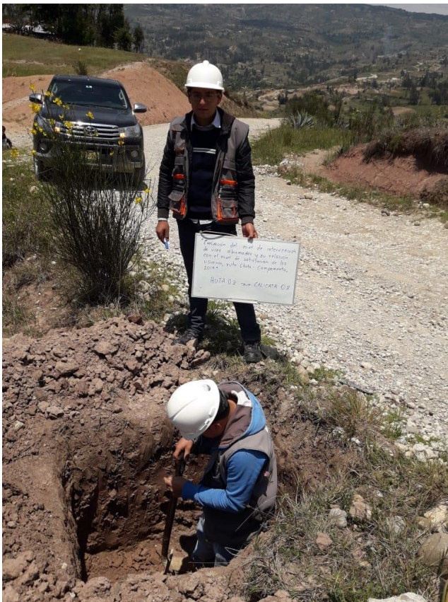
Figura 10. Muestreo de Suelos Calicata 2 Ruta 2 Chota – Campamento
