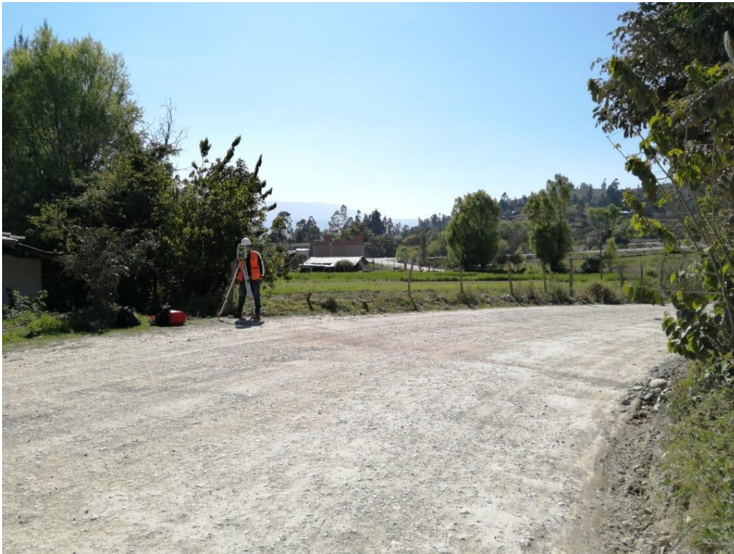
Figura 3. Levantamiento Topográfico en la Ruta 3, Chota – Campamento
