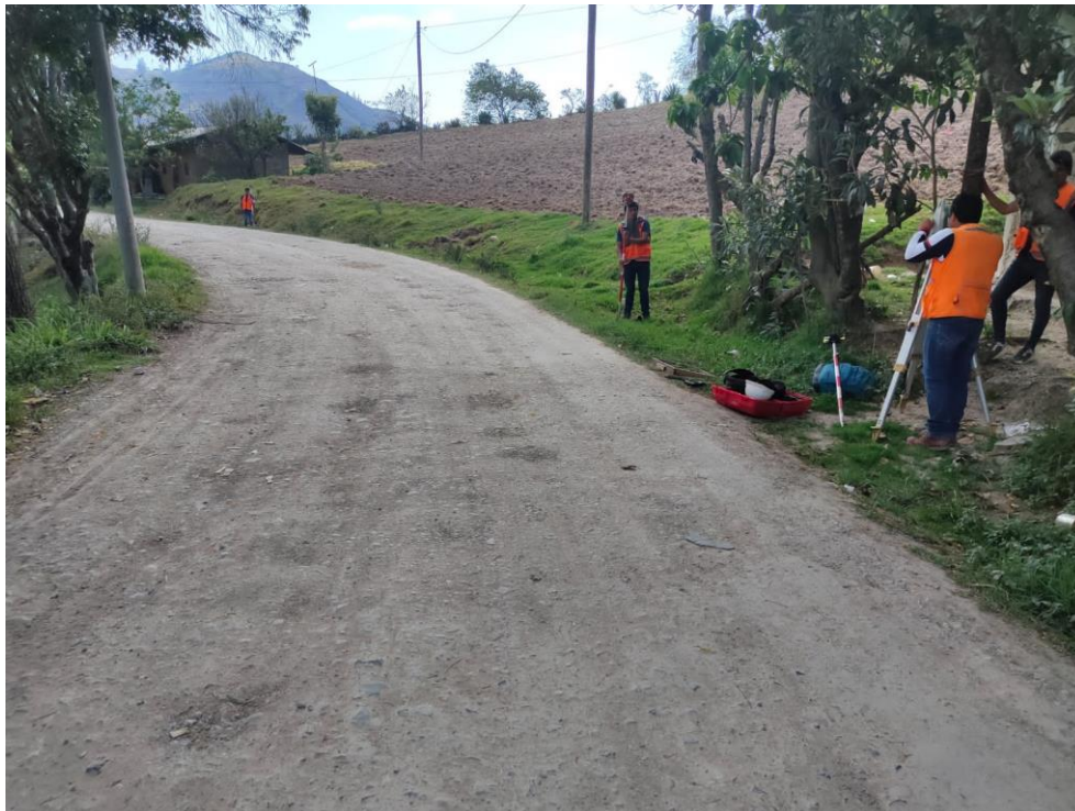
Figura 2. Levantamiento Topográfico en la Ruta 2, Chota – Campamento
