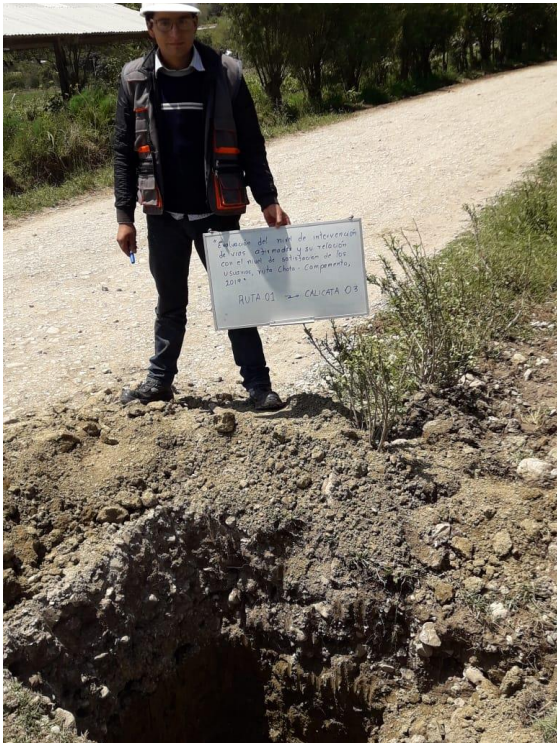
Figura 7. Muestreo de Suelos Calicata 3 Ruta 1 Chota – Campamento
