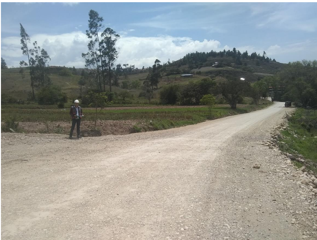
Figura 22. Estación N° 3, en la Ruta 2, Tráfico Vehicular
