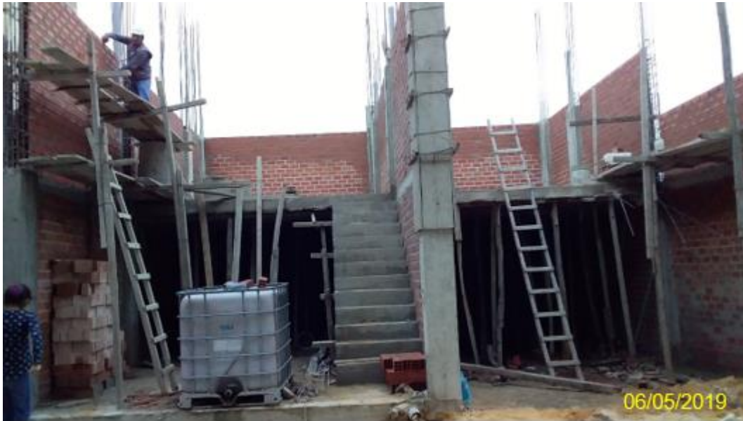
Fotografía 13. Mano de obra trabajando en la Vivienda 7
