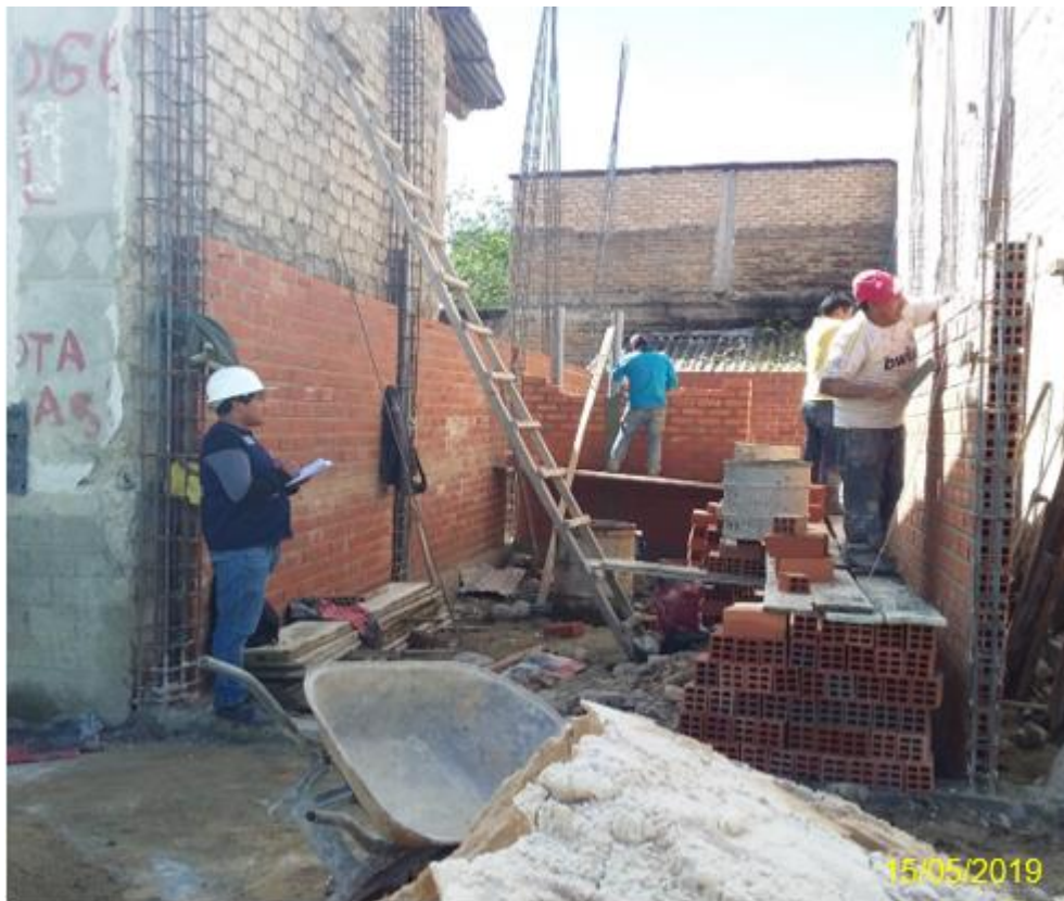
Fotografía 19. Mano de obra trabajando en la Vivienda 10
