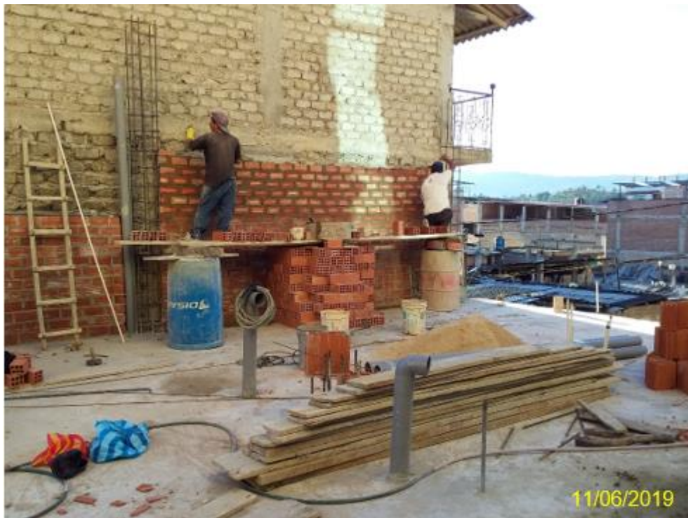
Fotografía 21. Mano de obra trabajando en la Vivienda 11
