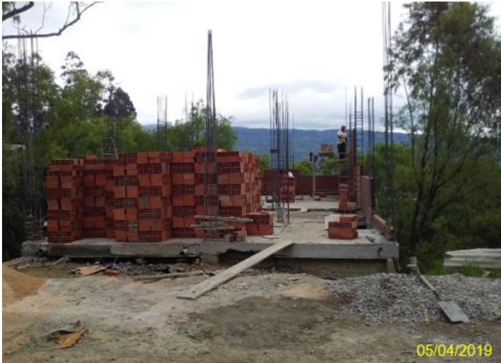
Fotografía 11. Mano de obra trabajando en la Vivienda 6
