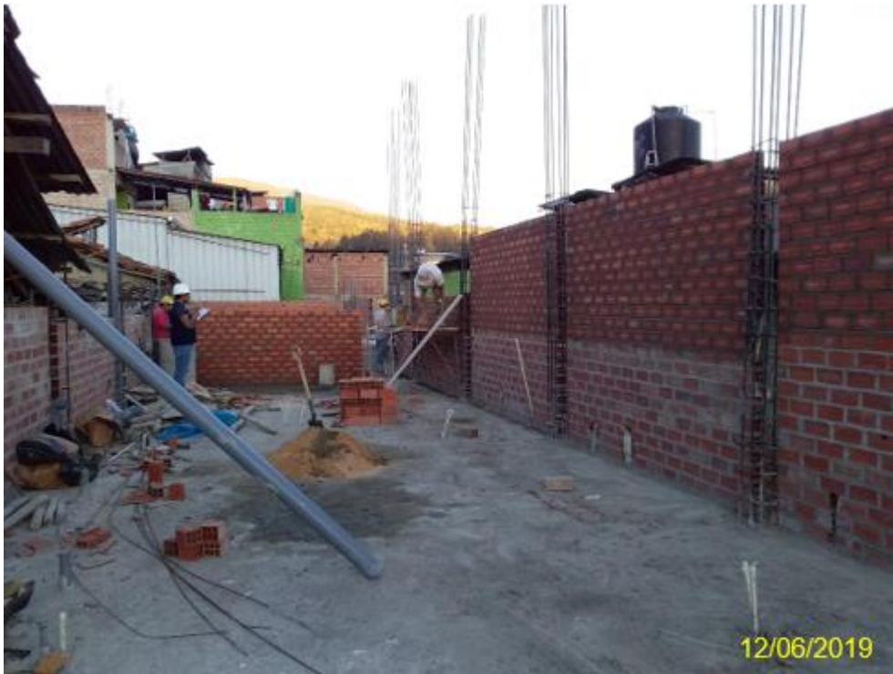
Fotografía 23. Mano de obra trabajando en la Vivienda 12
