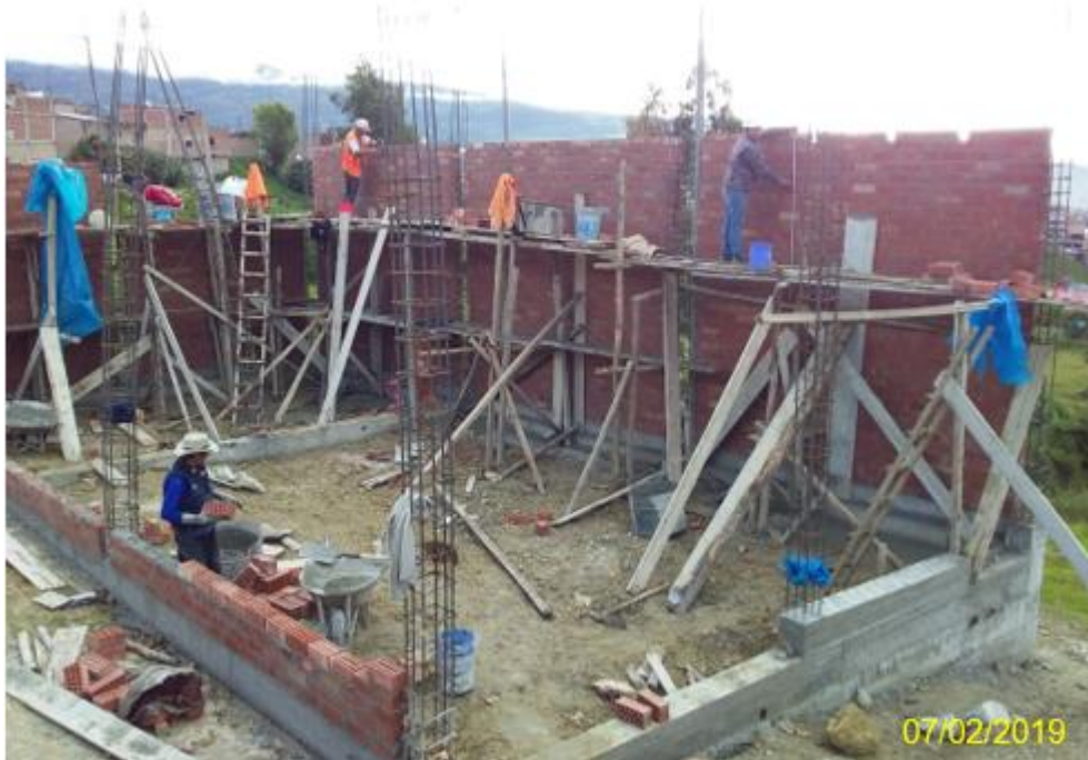
Fotografía 1. Mano de obra trabajando en la Vivienda 1
