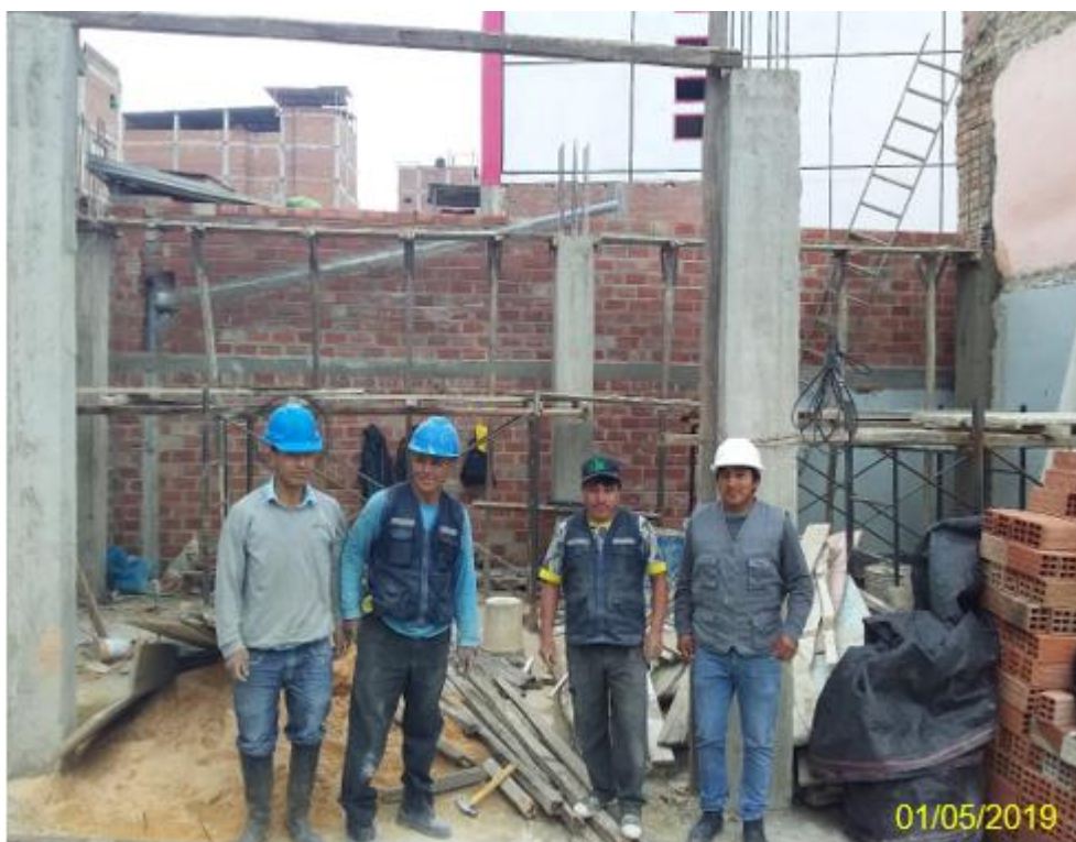
Fotografía 15. Mano de obra trabajando en la Vivienda 8
