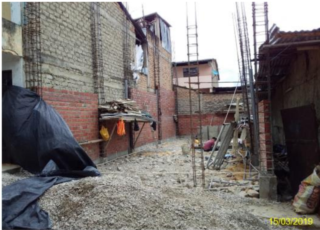
Fotografía 7. Mano de obra trabajando en la Vivienda 4
