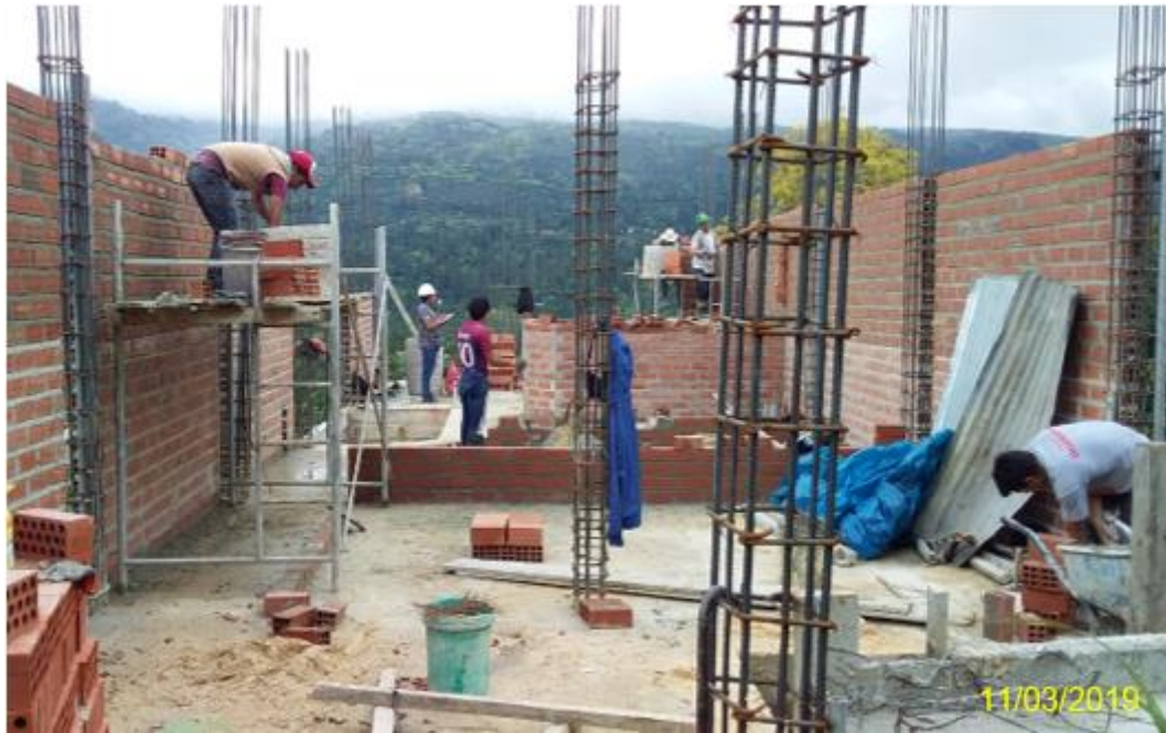
Fotografía 17. Mano de obra trabajando en la Vivienda 9
