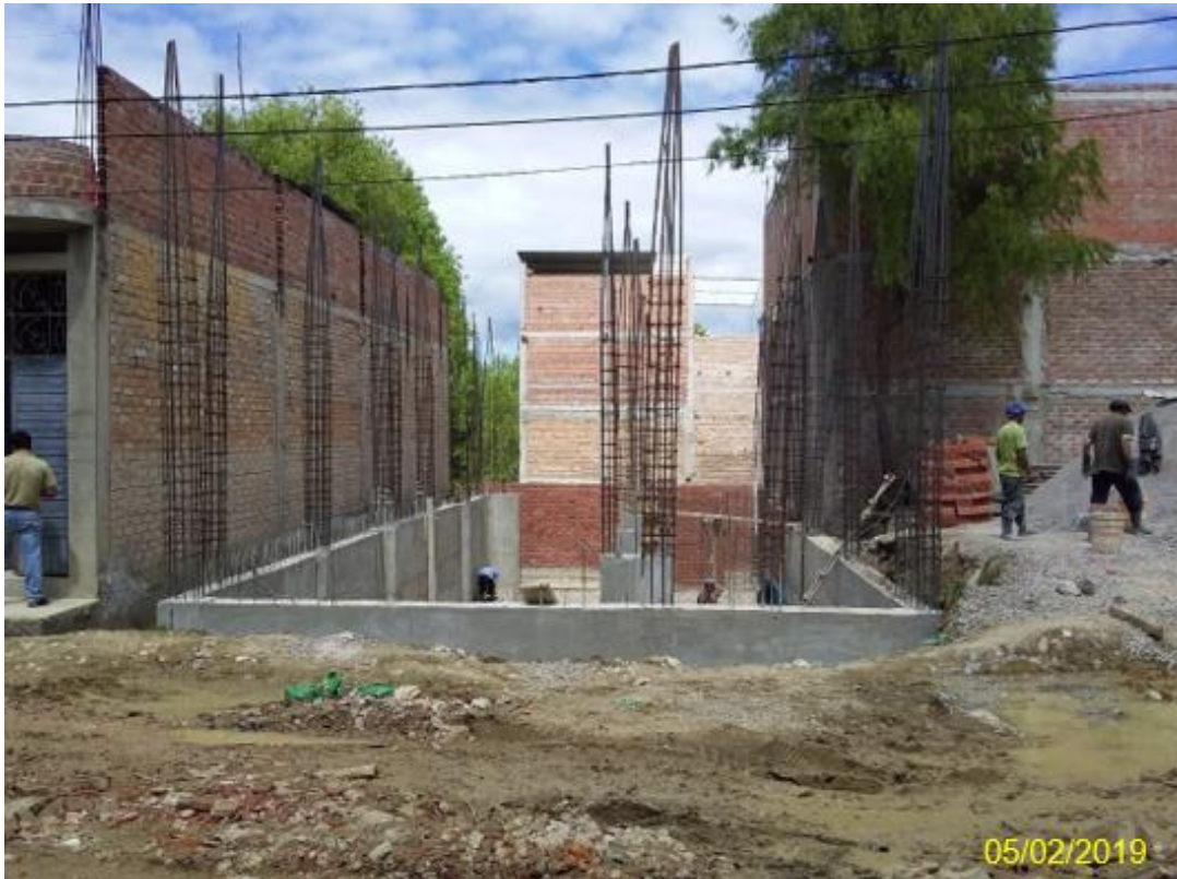
Fotografía 5. Mano de obra trabajando en la Vivienda 3
