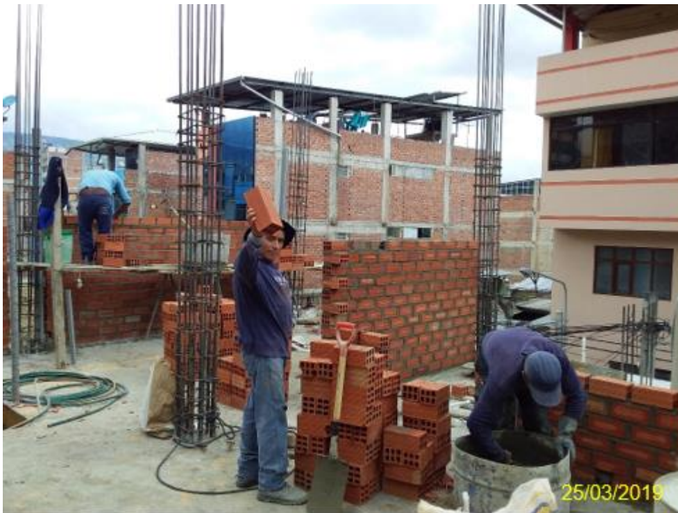
Fotografía 9. Mano de obra trabajando en la Vivienda 5
