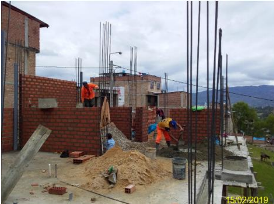
Fotografía 3. Mano de obra trabajando en la Vivienda 2
