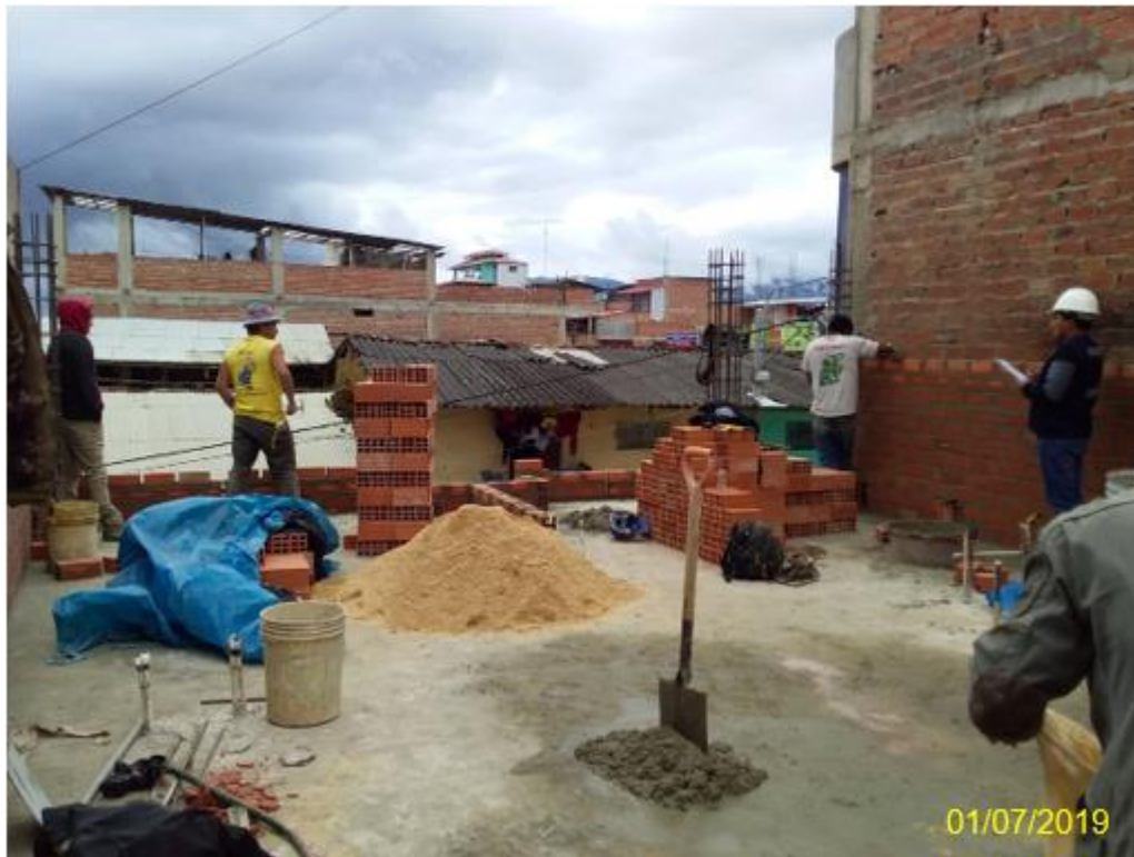
Fotografía 25. Mano de obra trabajando en la Vivienda 13
