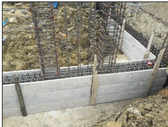
Proceso de dosificación y vaciado del concreto.
