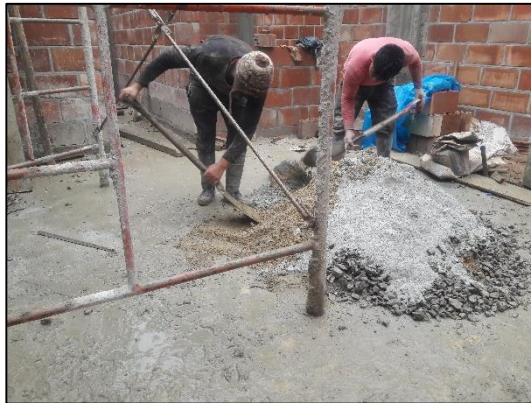
Proceso de dosificación y vaciado del concreto.
