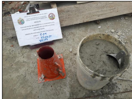
Proceso de dosificación y vaciado del concreto.
