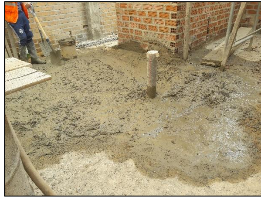
Proceso de dosificación y vaciado del concreto.
