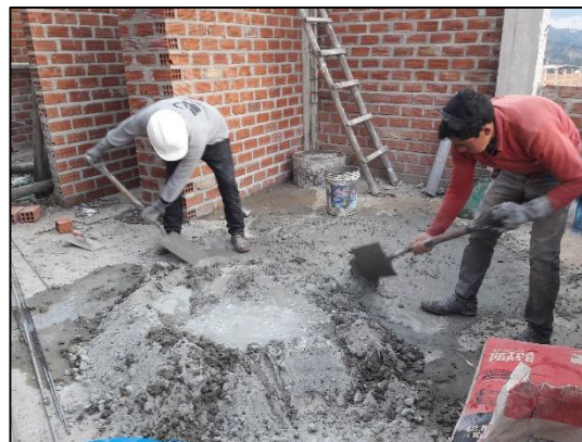
Proceso de dosificación y vaciado del concreto.
