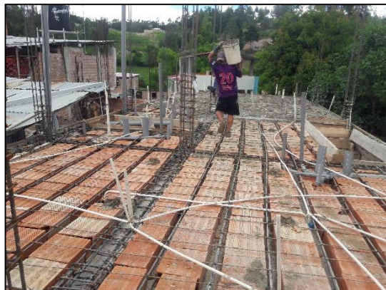
Proceso de dosificación y vaciado del concreto.
