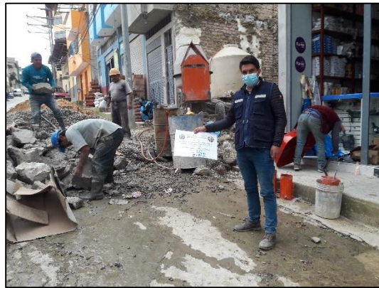
Proceso de dosificación y vaciado del concreto.
