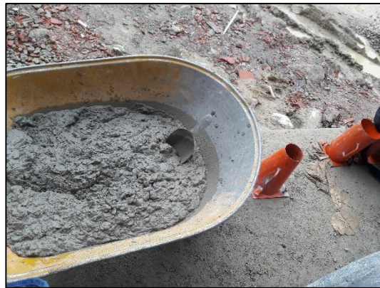
Proceso de dosificación y vaciado del concreto.
