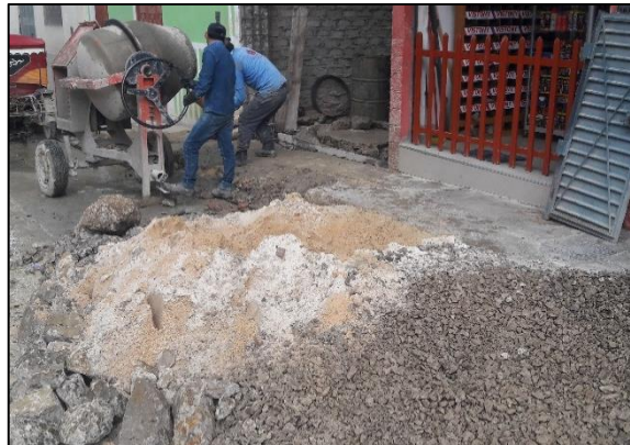
Proceso de dosificación y vaciado del concreto.
