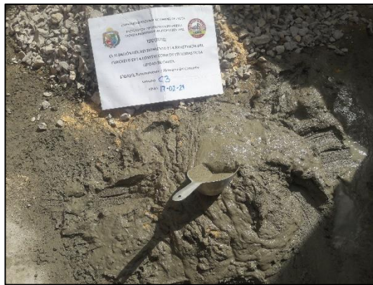
Proceso de dosificación y vaciado del concreto.
