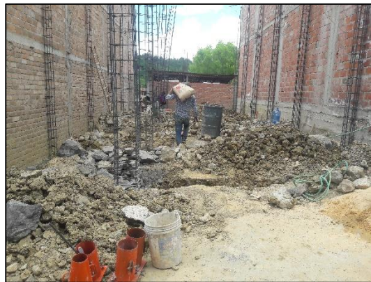
Proceso de dosificación y vaciado del concreto.
