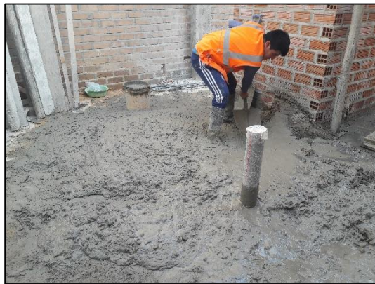
Proceso de dosificación y vaciado del concreto.
