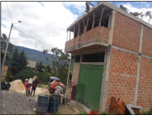
Proceso de dosificación y vaciado del concreto.
