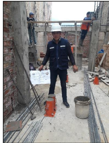
Ensayo de revenimiento del concreto y muestreo de probetas.
