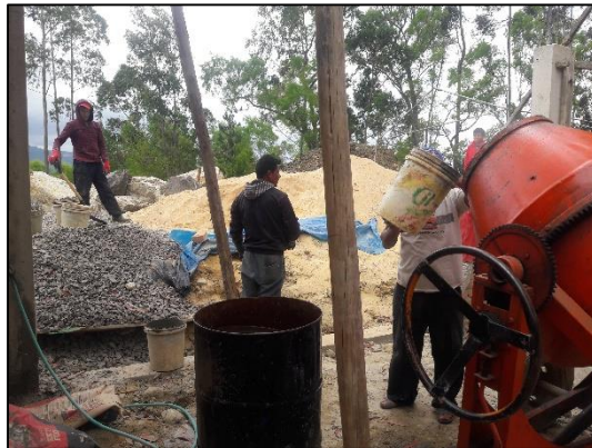
Proceso de dosificación y vaciado del concreto.
