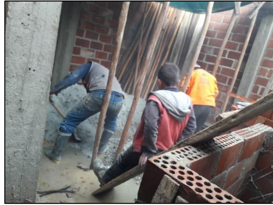
Proceso de dosificación y vaciado del concreto.
