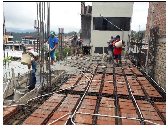
Proceso de dosificación y vaciado del concreto.
