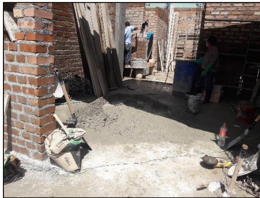
Proceso de dosificación y vaciado del concreto.
