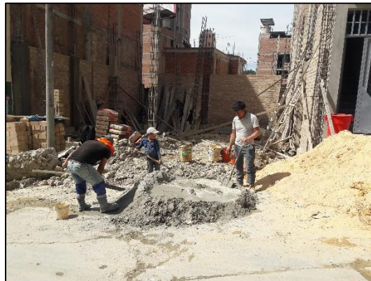
Proceso de dosificación y vaciado del concreto.
