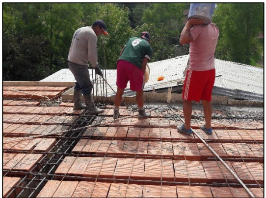
Proceso de dosificación y vaciado del concreto.
