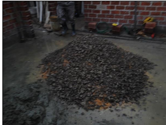
Proceso de dosificación y vaciado del concreto.
