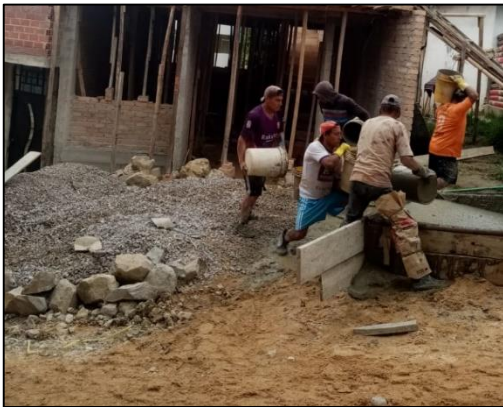
Proceso de dosificación y vaciado del concreto.
