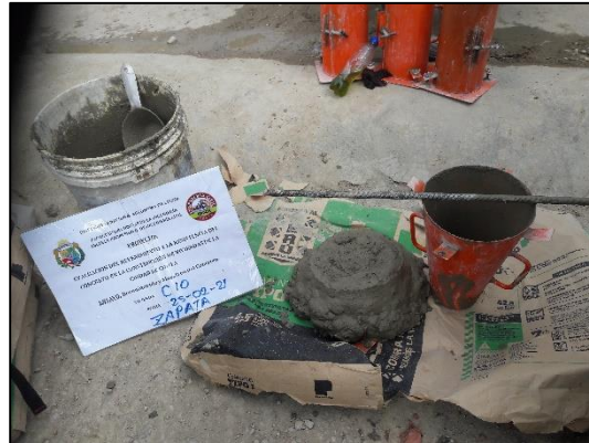
Proceso de dosificación y vaciado del concreto.
