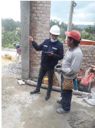
Proceso de dosificación y vaciado del concreto.
