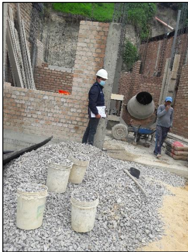
Proceso de dosificación y vaciado del concreto.
