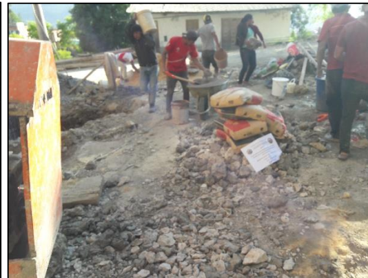
Proceso de dosificación y vaciado del concreto.
