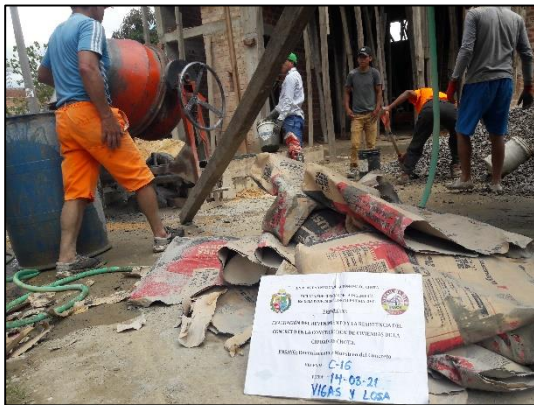
Proceso de dosificación y vaciado del concreto.
