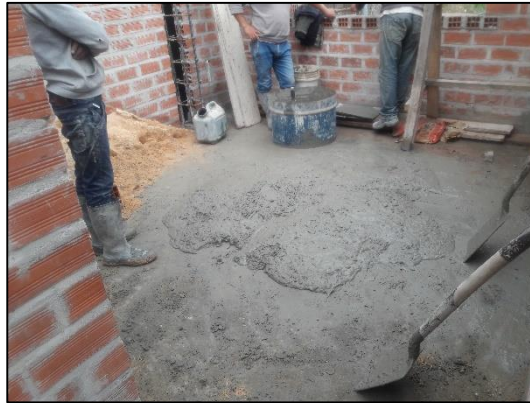
Proceso de dosificación y vaciado del concreto.
