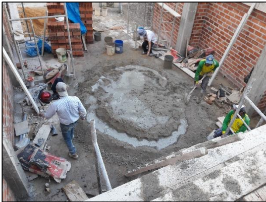
Proceso de dosificación y vaciado del concreto.
