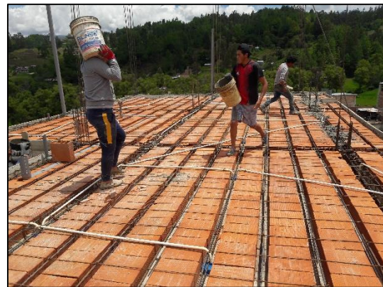
Proceso de dosificación y vaciado del concreto.
