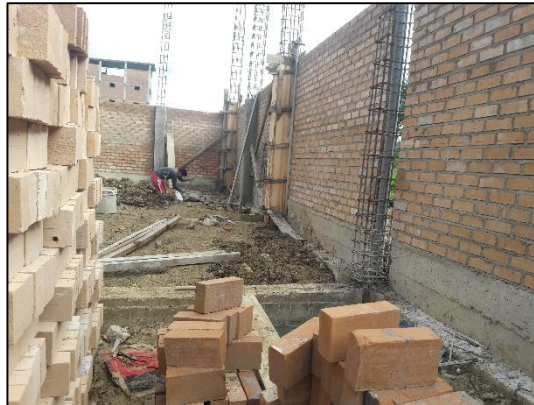
Proceso de dosificación y vaciado del concreto.
