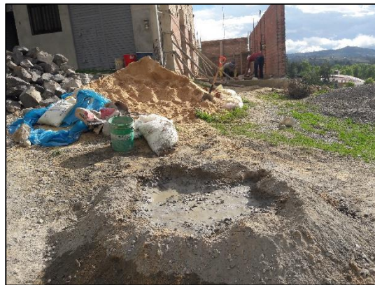
Proceso de dosificación y vaciado del concreto.
