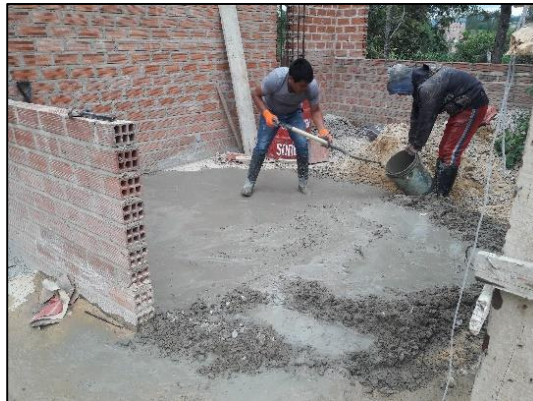
Proceso de dosificación y vaciado del concreto.
