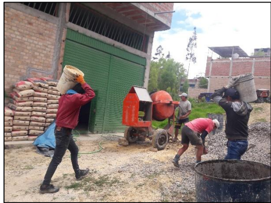
Proceso de dosificación y vaciado del concreto.
