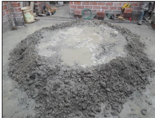
Proceso de dosificación y vaciado del concreto.
