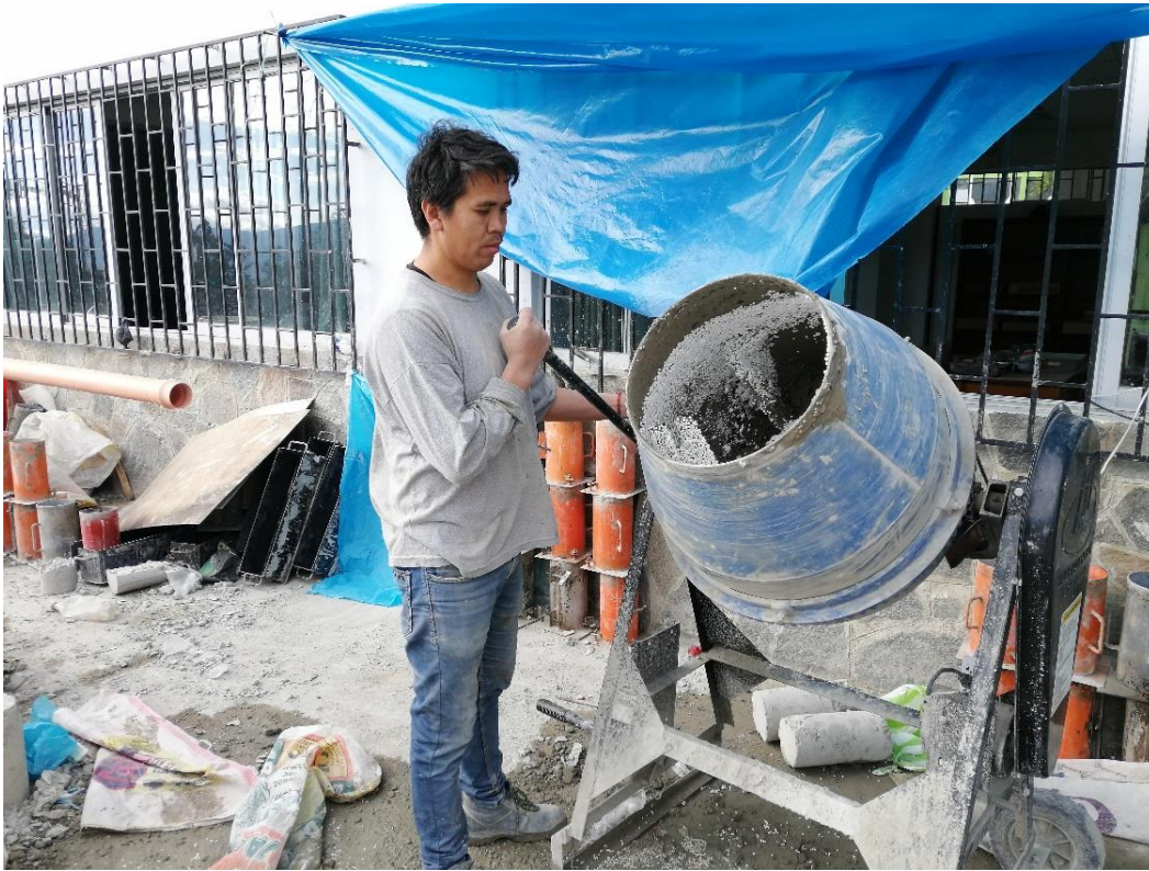
Fotografía 5. Elaboración de la mezcla de concreto con poliestireno
