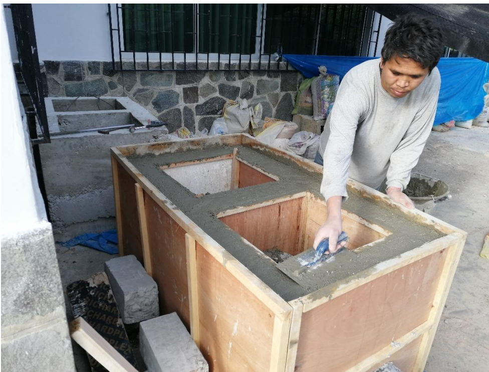
Fotografía 11. Proceso de elaboración de las estructuras termo- acústicos con poliestireno al 12.5%
