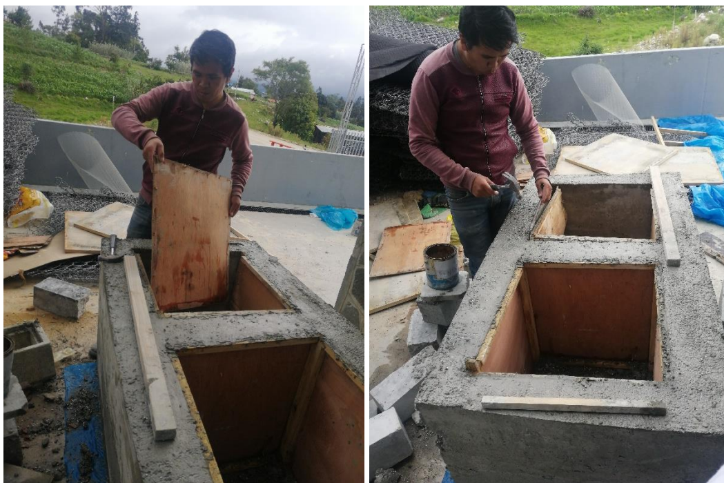
Fotografía 12. Desencofrado de las estructuras a escala
