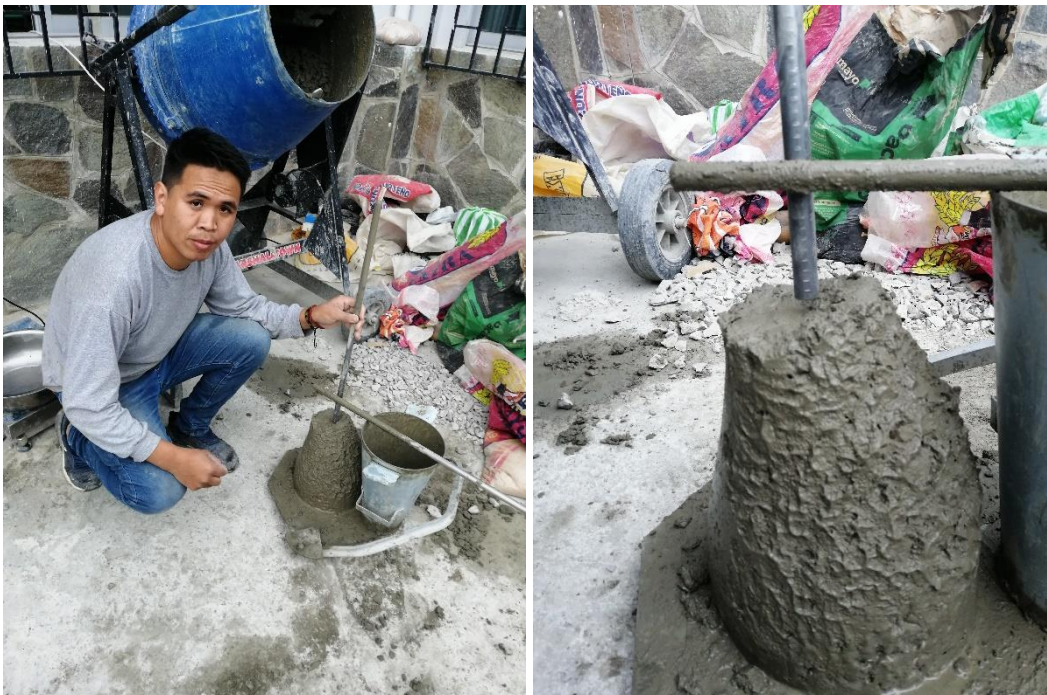
Fotografía 6. Determinación del Slump en la mezcla de concreto con poliestireno
