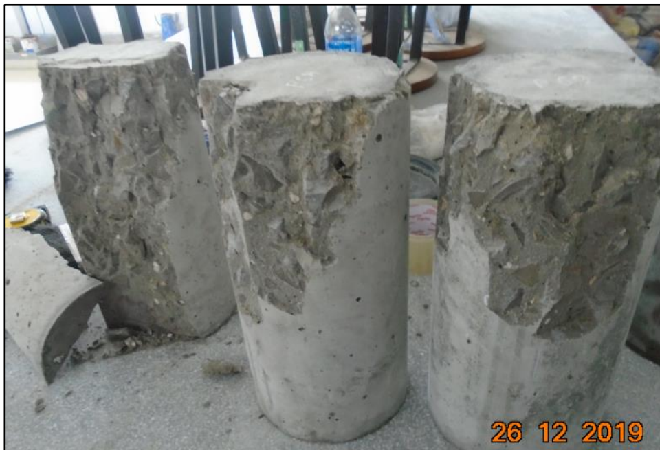
Foto N° 81: Fracturas tipo 2 y 5, presentadas en concretos elaborados con agregados de cerro (Cantera Conchán y San Juan del Suro).
