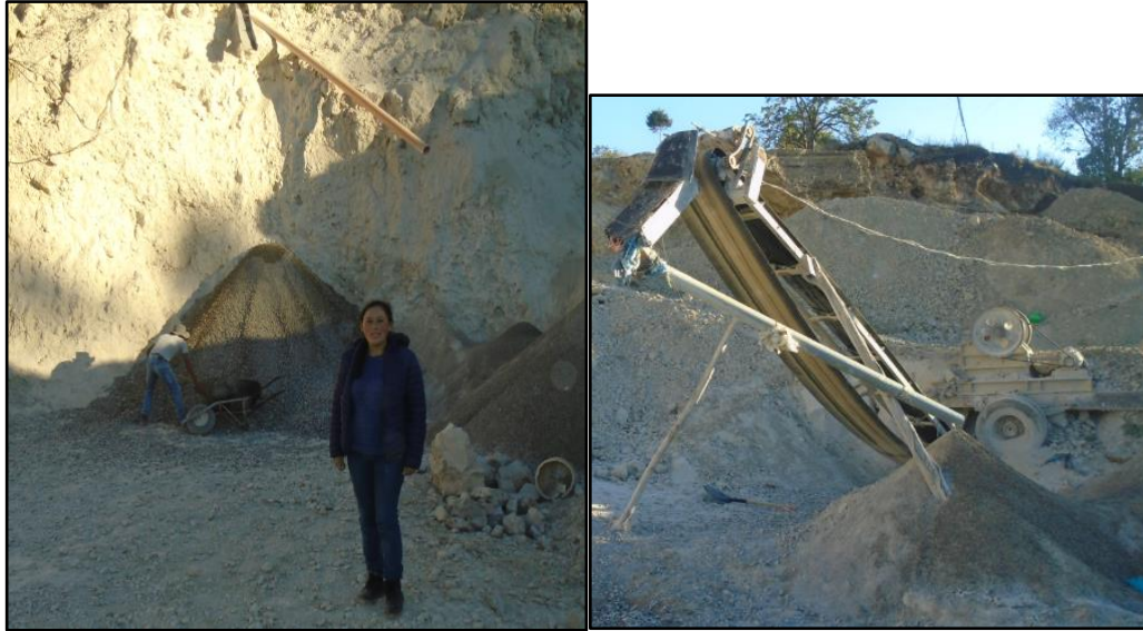
Foto N° 4. Izquierda. Pila de agregado grueso triturado, cantera de cerro (Los Reyes)
