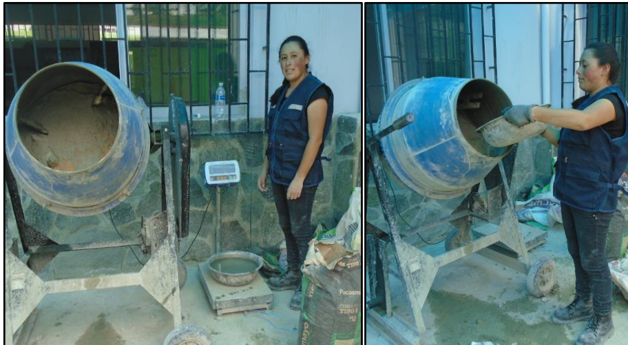
Foto N° 59. Izquierda. Medición de agua de mezcla. Foto N° 60. Derecha. Colocación de agregados a la mezcladora.
