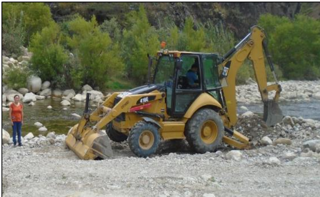
Foto N° 6. Cargador frontal extrayendo agregados del cauce del río Chotano.
