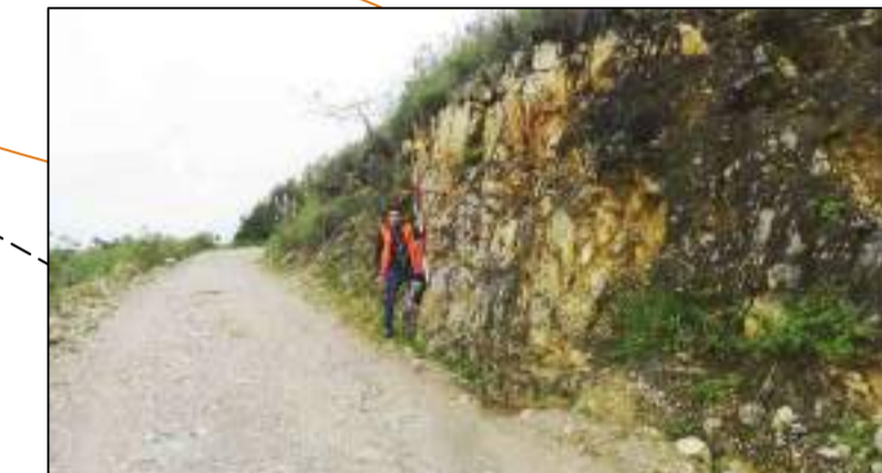
VISTA PANORÁMICA DEL BM N° 02 SOBRE ROCA FIJA
