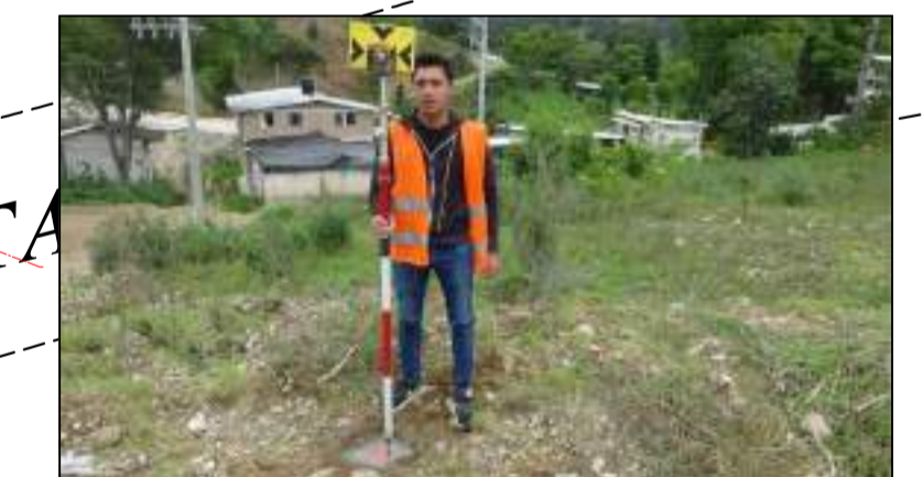
VISTA PANORÁMICA PUNTO FIJO N° 01 MONUMENTADO
