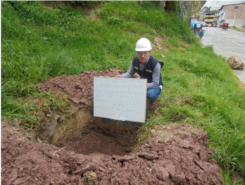
Fotografía 9. Calicata 1 en la Av. Micaela Bastidas
