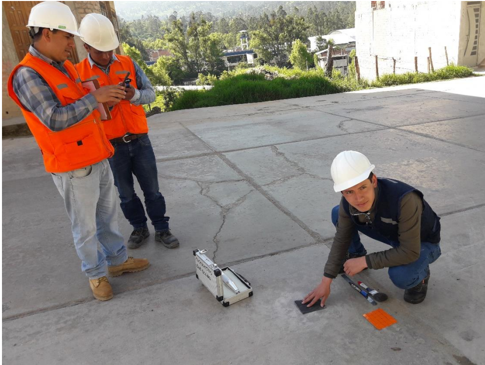
Fotografía 5. Preparación para el ensayo de esclerometría
