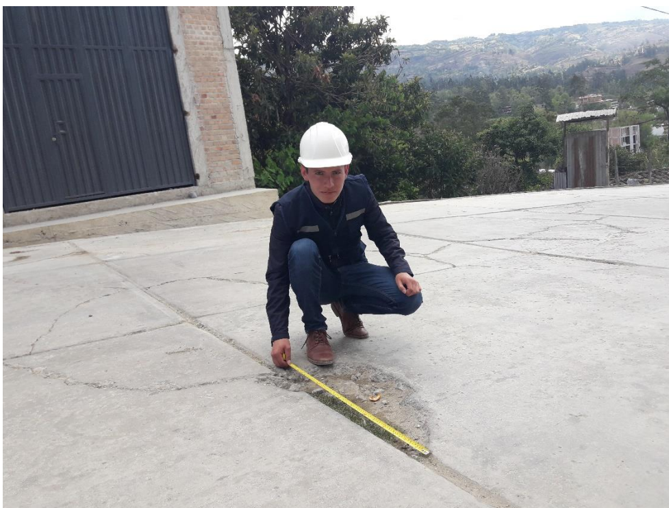
Fotografía 2. Tesista registrando fallas en la cuadra 3 de la Av. Micaela Bastidas
