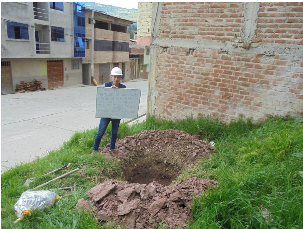
Fotografía 10. Calicata 2 en la Av. Micaela Bastidas
