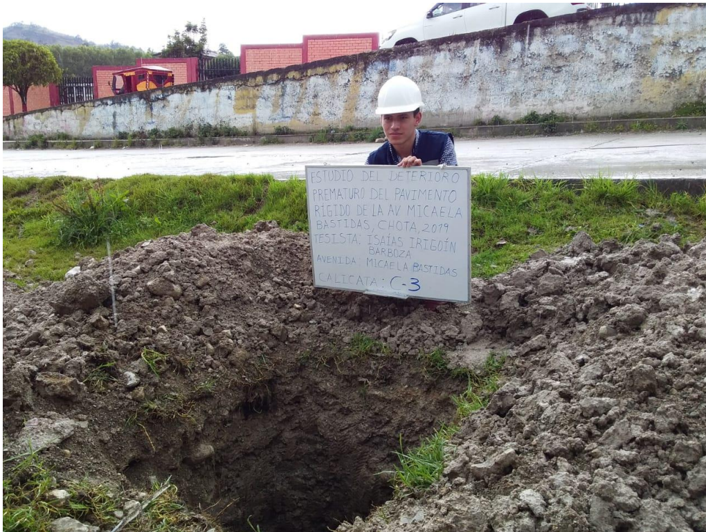
Fotografía 11. Calicata 3 en la Av. Micaela Bastidas
