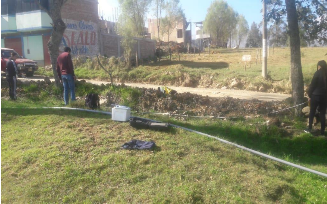
Figura 17. Determinación de caudal en la estación QSmat.01
