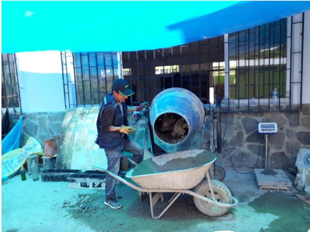
**Fotografía 10. Adición de fibras de acero a la mezcla**
