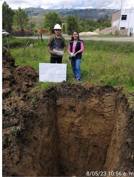
Fotografía 04: *Extracción de muestras de las calicatas – calicata 4*
