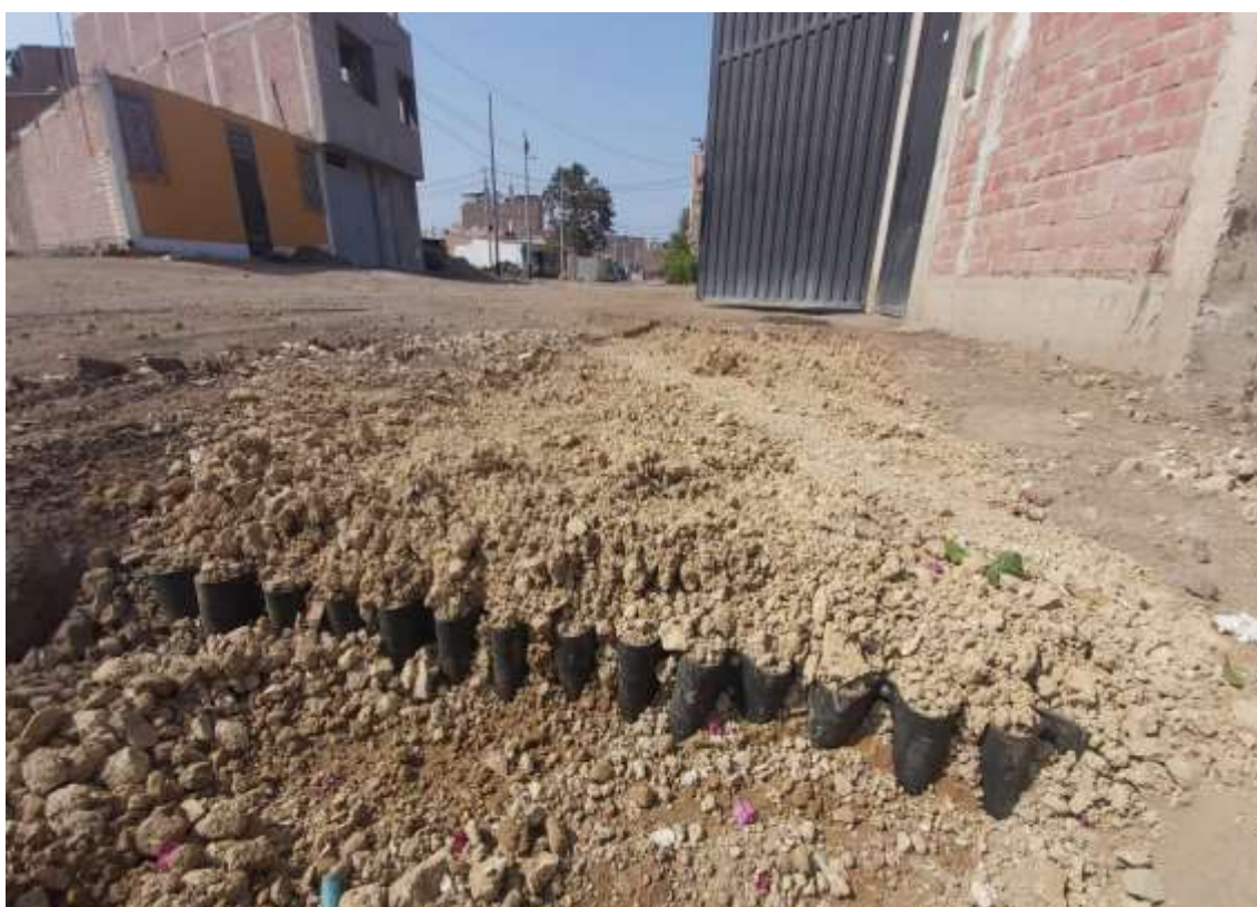
Fotografía 99. Vista de las geoceldas romboidales con el afirmado
