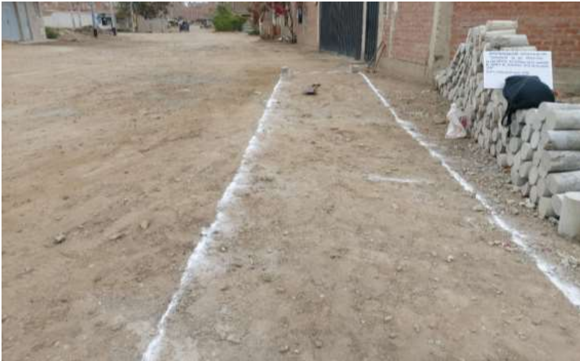
Fotografía 79. Trazo para prototipos en campo
