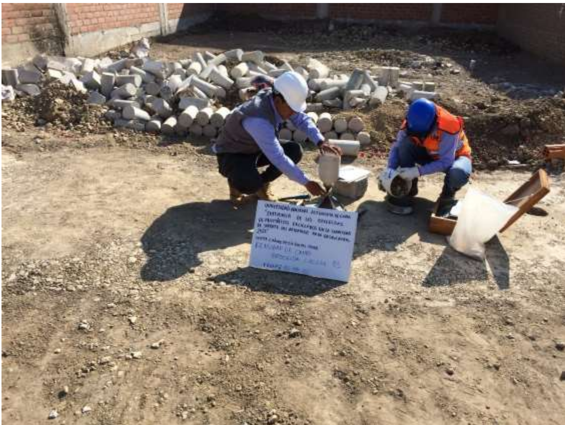
Fotografía 123. El tesista vertiendo a arena de Ottawa en el prototipo de a geocelda 03
