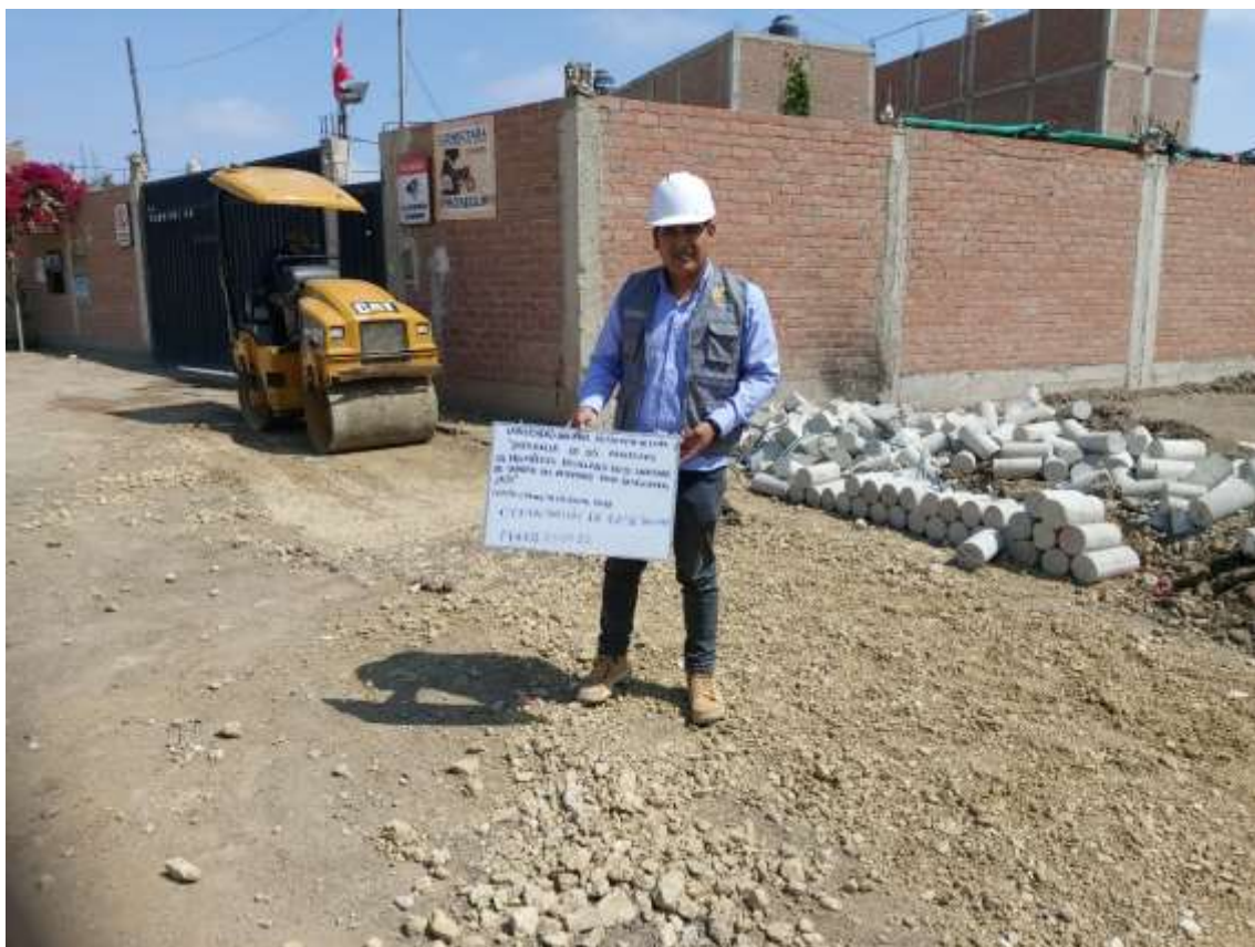
Fotografía 105. Compactación de la base con rodillo vibratorio
