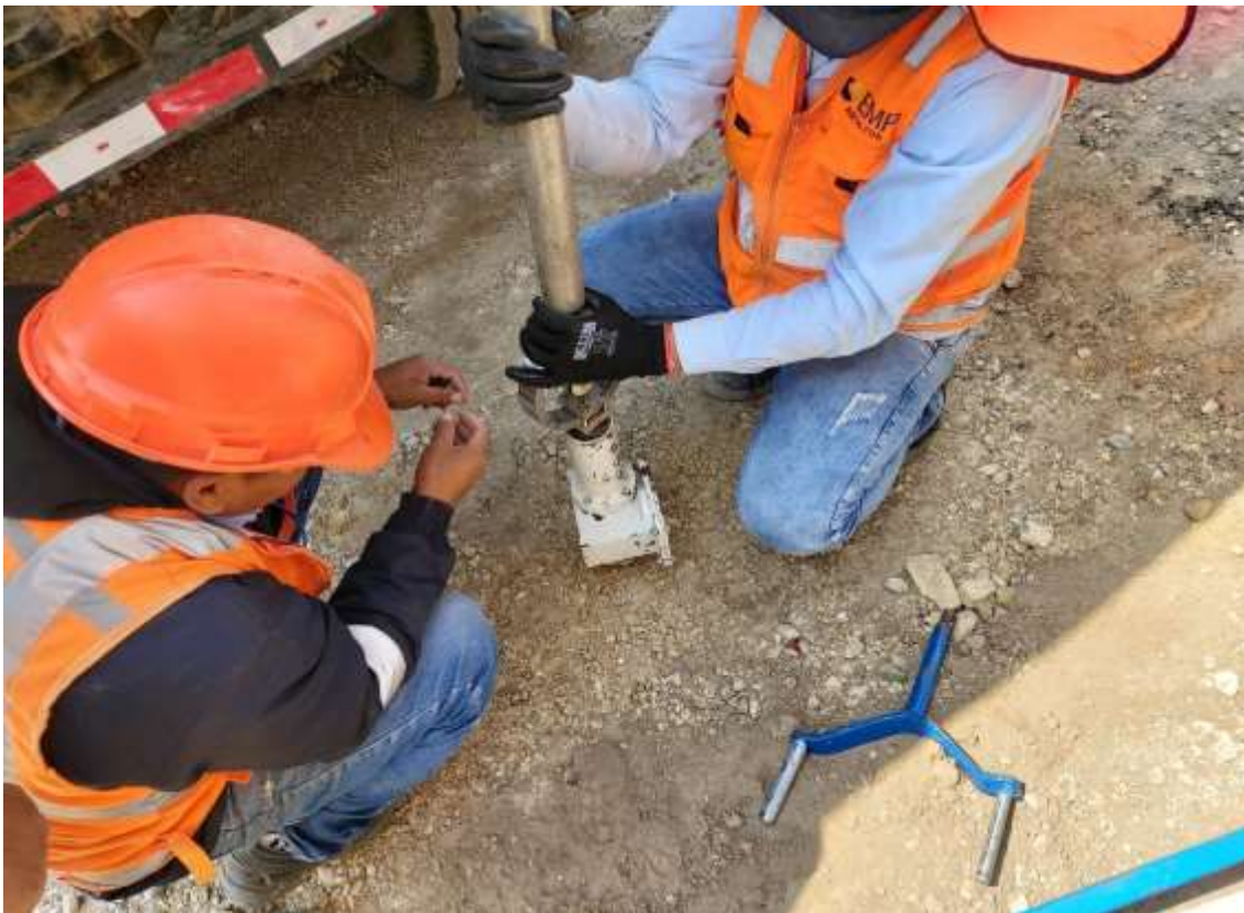
Fotografía 152. Instalación del equipo de CBR in situ geocelda romboidal 03
