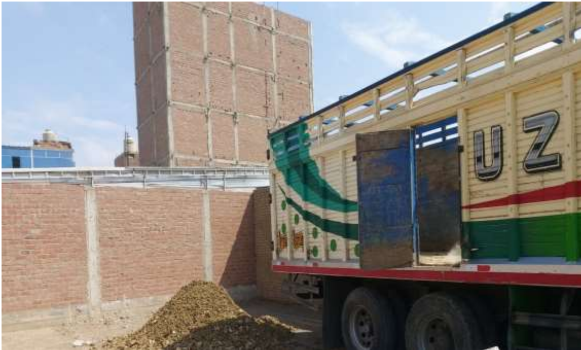
Fotografía 92. Descarga de afirmado para prototipos de campo
