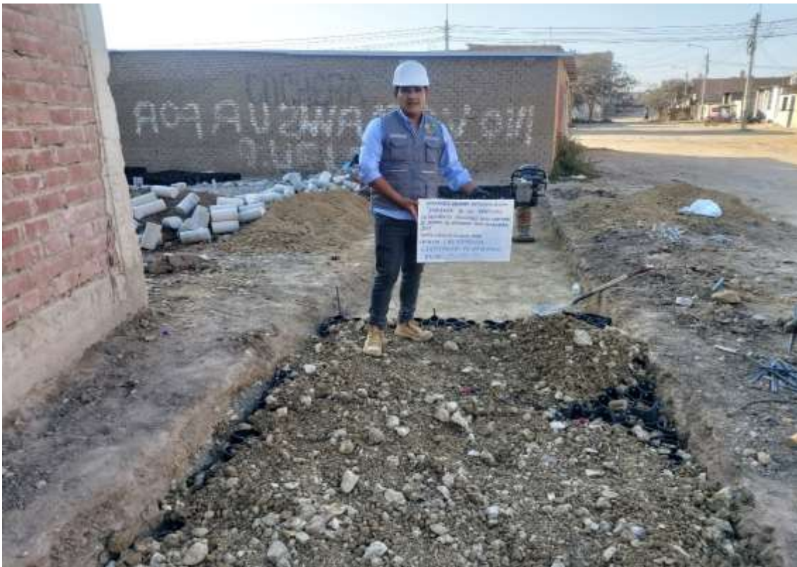
Fotografía 97. Compactación de base de prototipo con geoceldas romboidales
