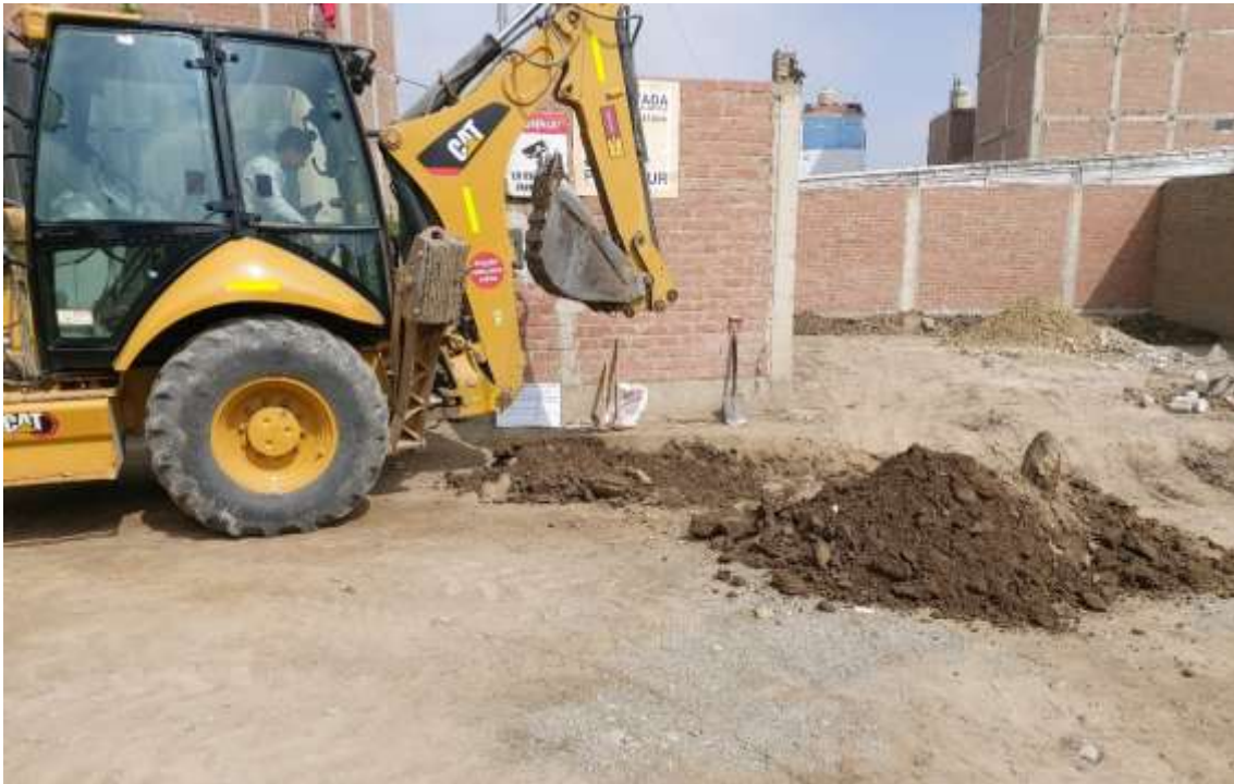
Fotografía 82. Nivelación de subrasante
