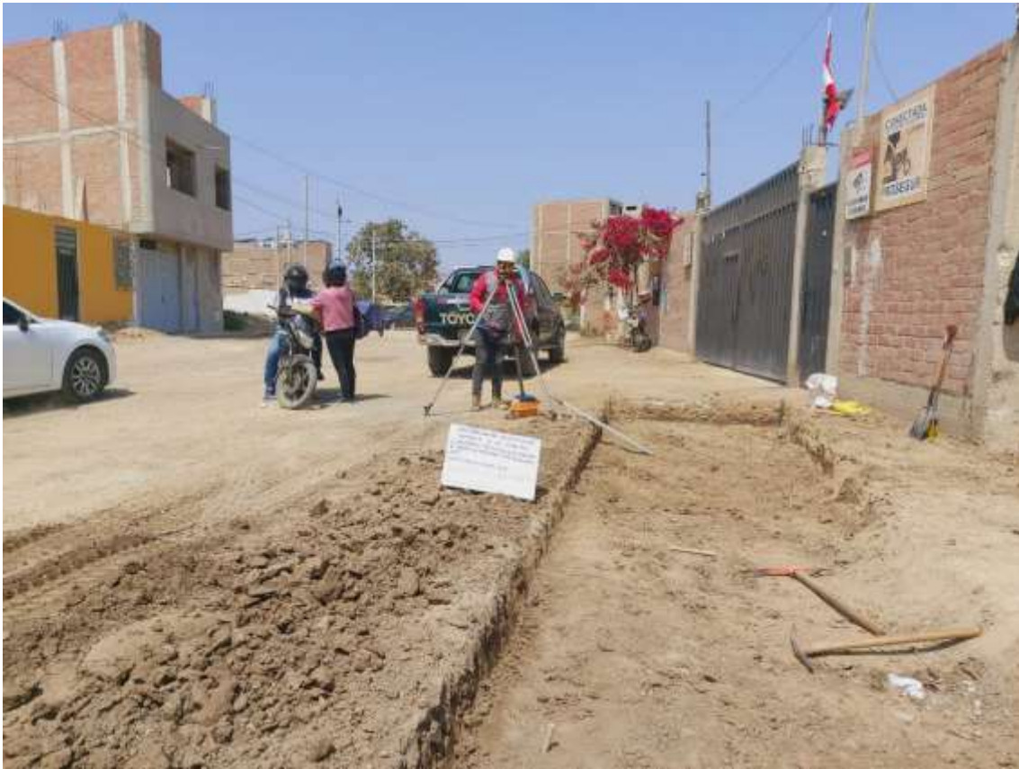
Fotografía 83. Nivelación de subrasante
