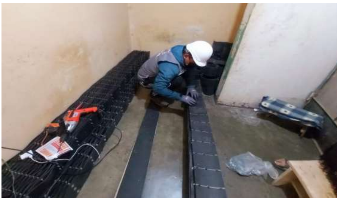
Fotografía 74. Unión de fajas para geoceldas romboidales
