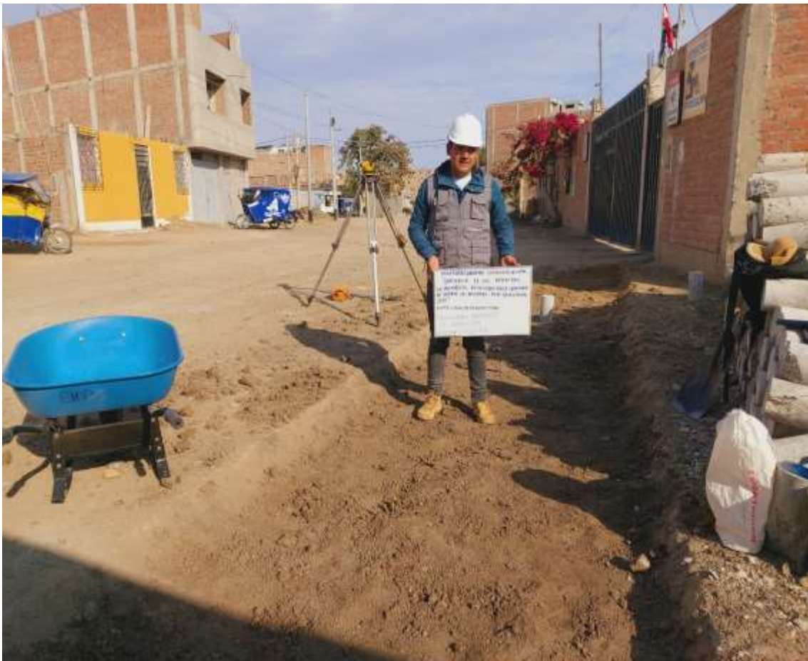
Fotografía 82. Nivelación de subrasante
