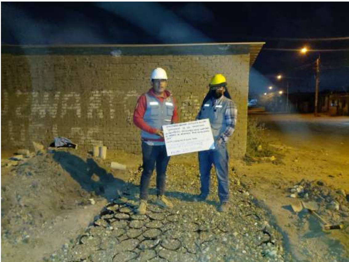
Fotografía 101. Colocación de afirmado en las geoceldas circulares
