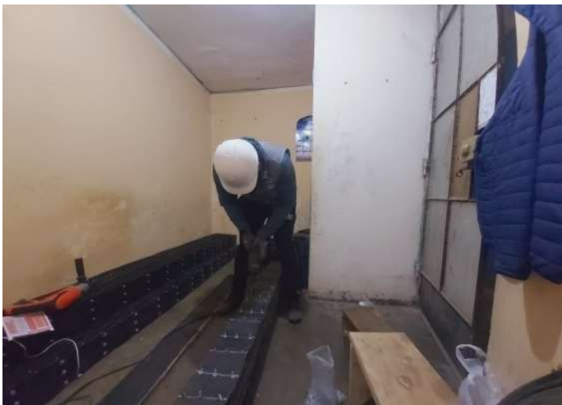
Fotografía 76. Unión de fajas para geoceldas romboidales
