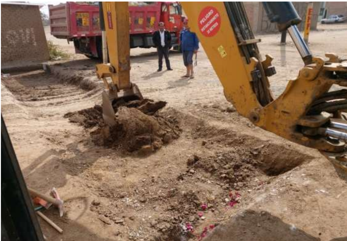
Fotografía 80. Excavación para prototipos
