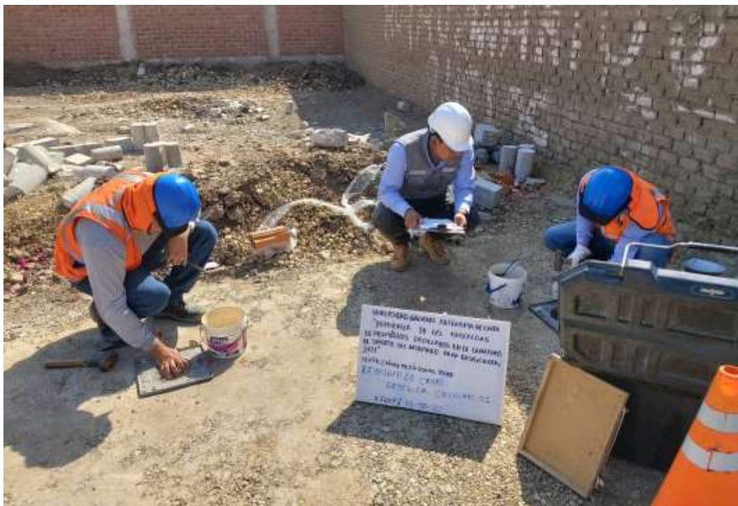
Proceso del Ensayo de Densidad de Campo
