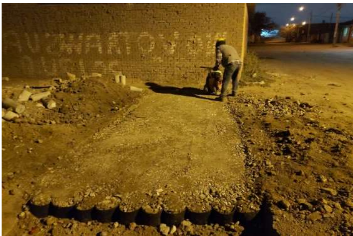
Fotografía 103. Compactación de la base con geoceladas circulares
