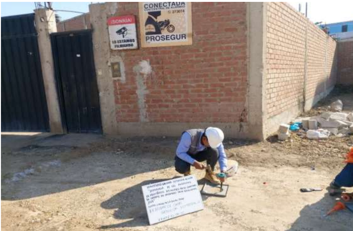
Nota: Perforación de agujero con cincel geocelda romboidal 02
