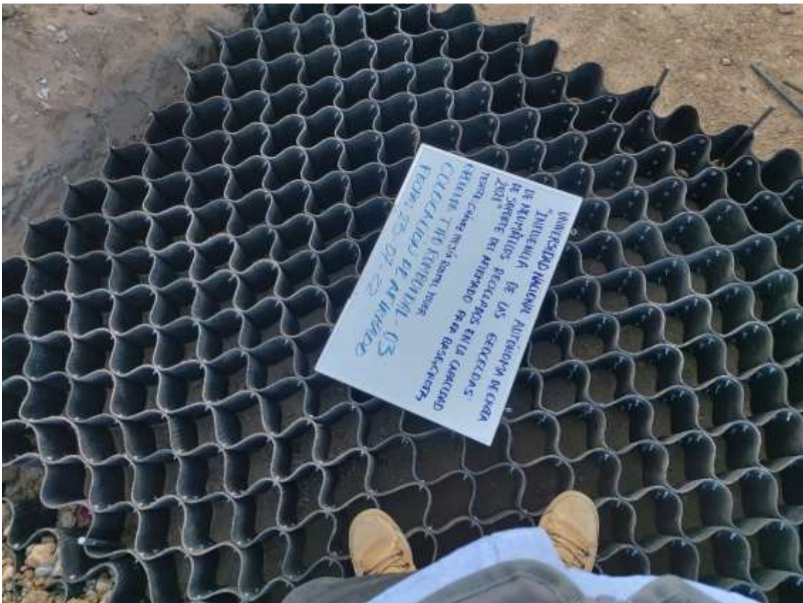
Fotografía 91. Instalación de geoceldas romboidales
