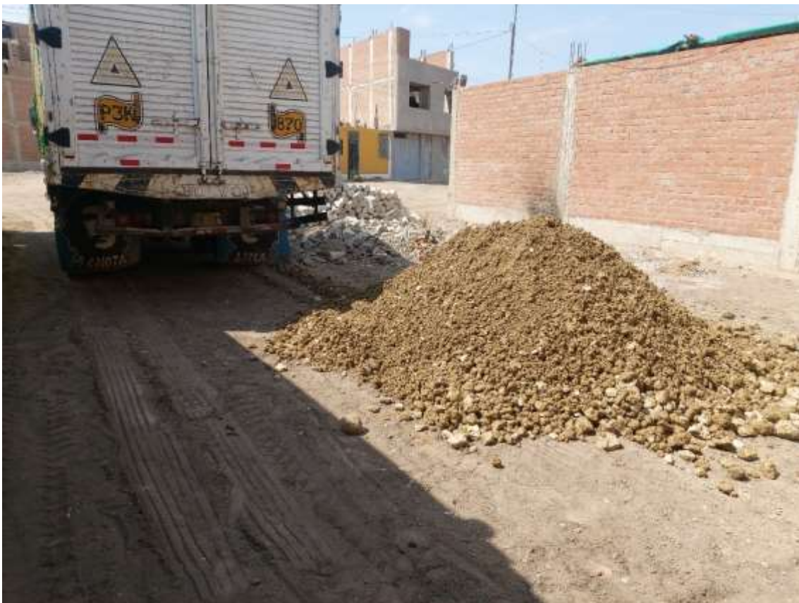
Fotografía 93. Descarga de afirmado para prototipos de campo
