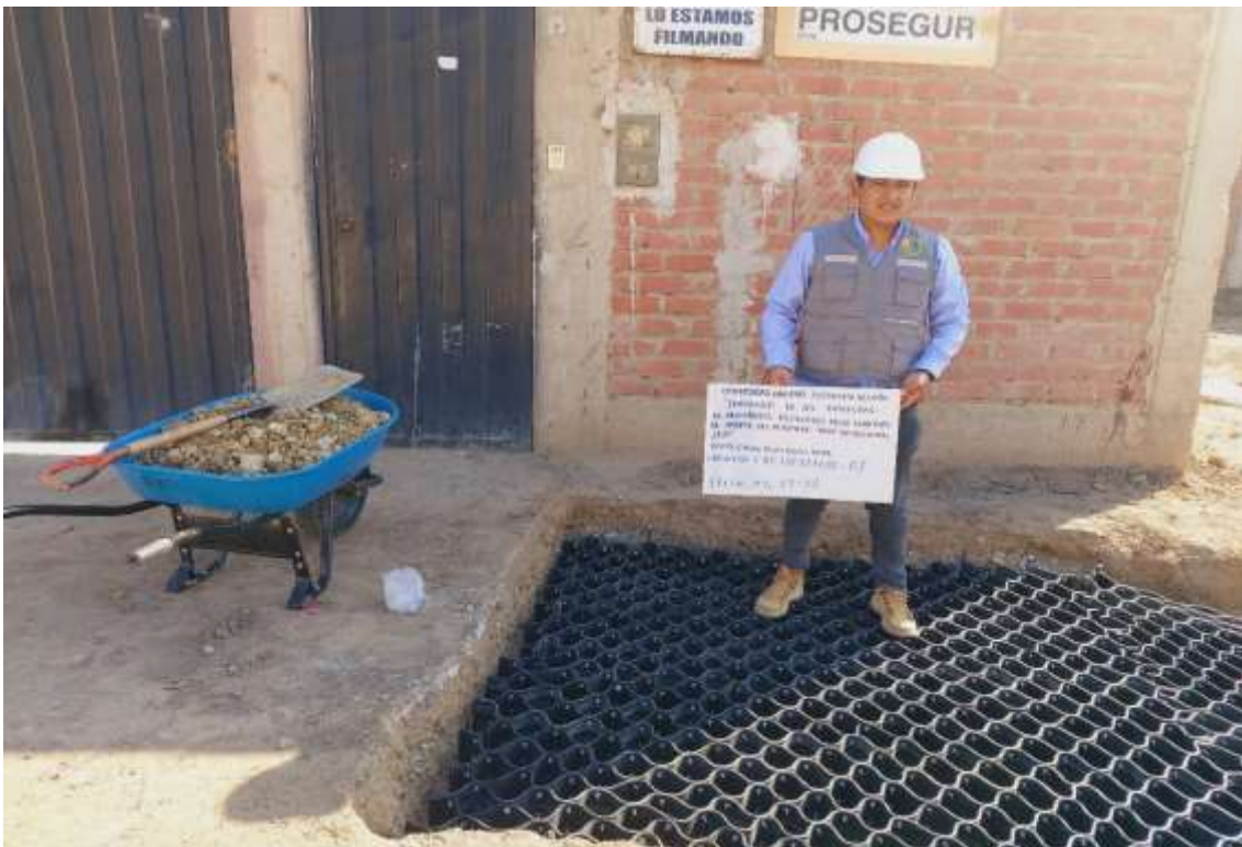
Fotografía 89. Instalación de geoceldas romboidales
