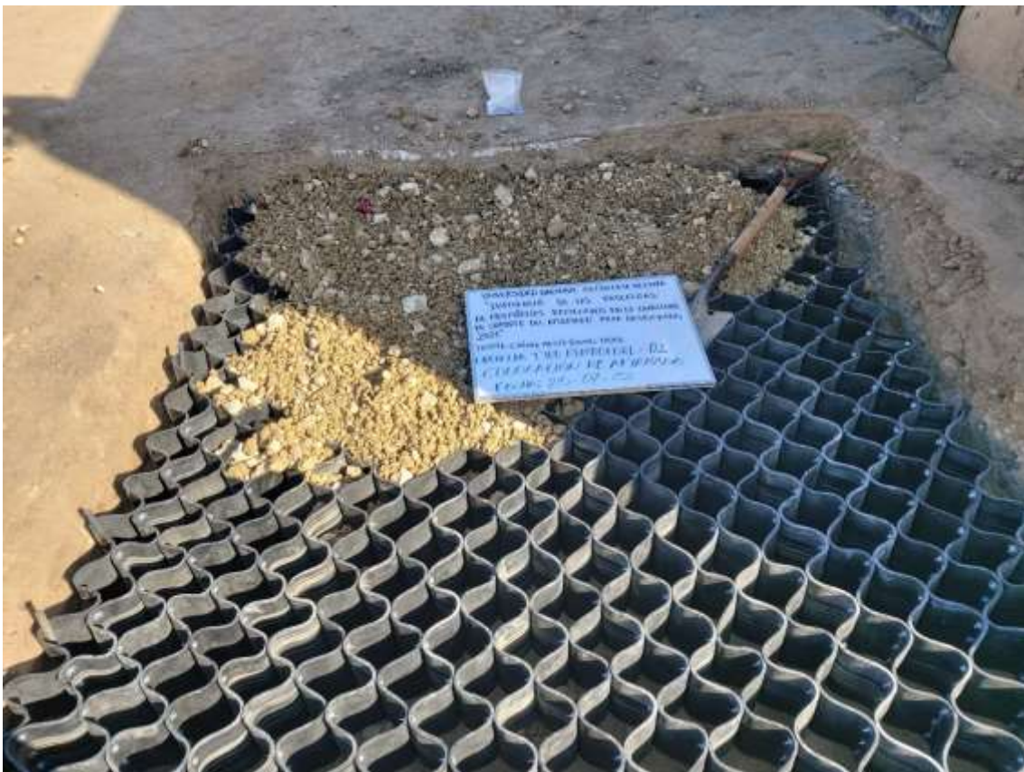
Fotografía 95. Colocación de afirmado en geoceldas romboidales
