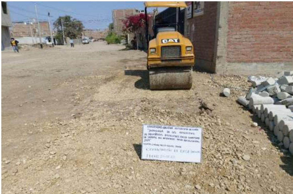
Fotografía 105. Compactación de la base con rodillo vibratorio
