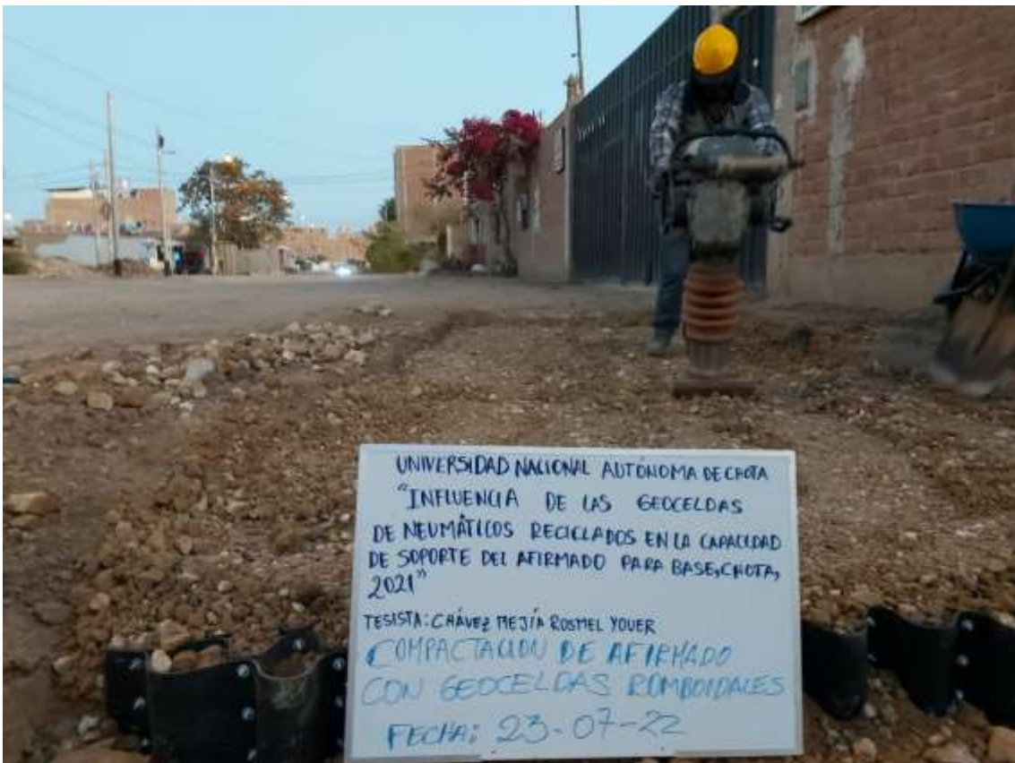
Fotografía 97. Compactación de base de prototipo con geoceldas romboidales
