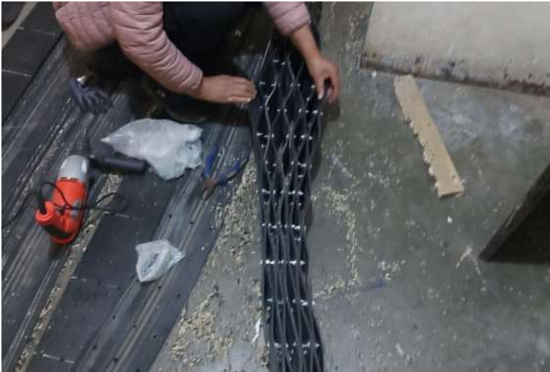
Fotografía 77. Formación de espacios romboidales para geocelda
