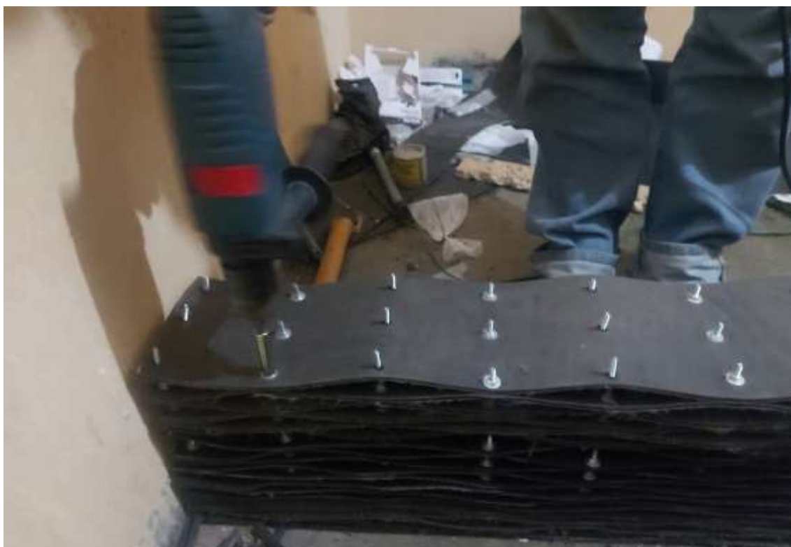
Fotografía 75. Unión de fajas para geoceldas romboidales
