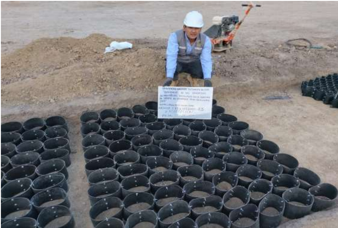
Fotografía 88. Instalación de geoceldas circulares
