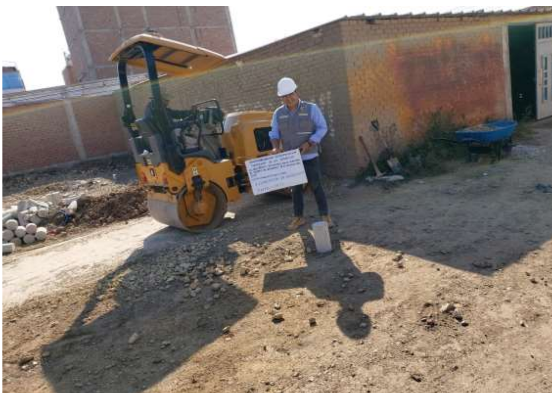
Fotografía 107. Compactación de la base con rodillo vibratorio
