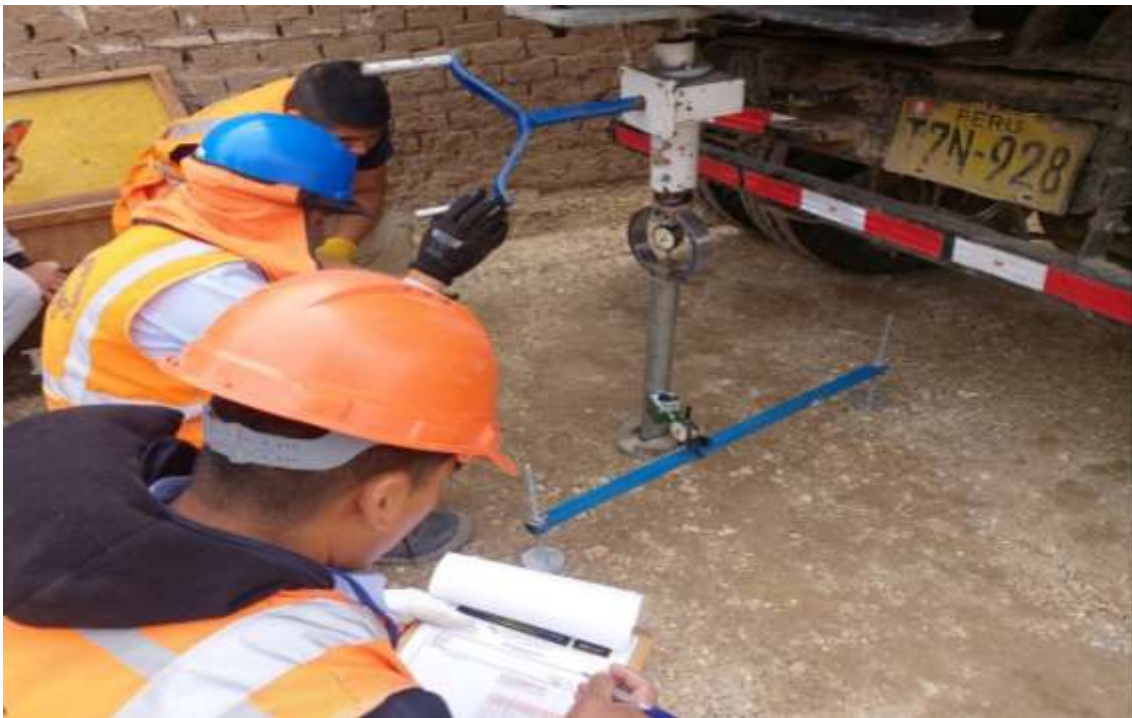
Fotografía 136. Aplicación de la carga al pistón de penetración
