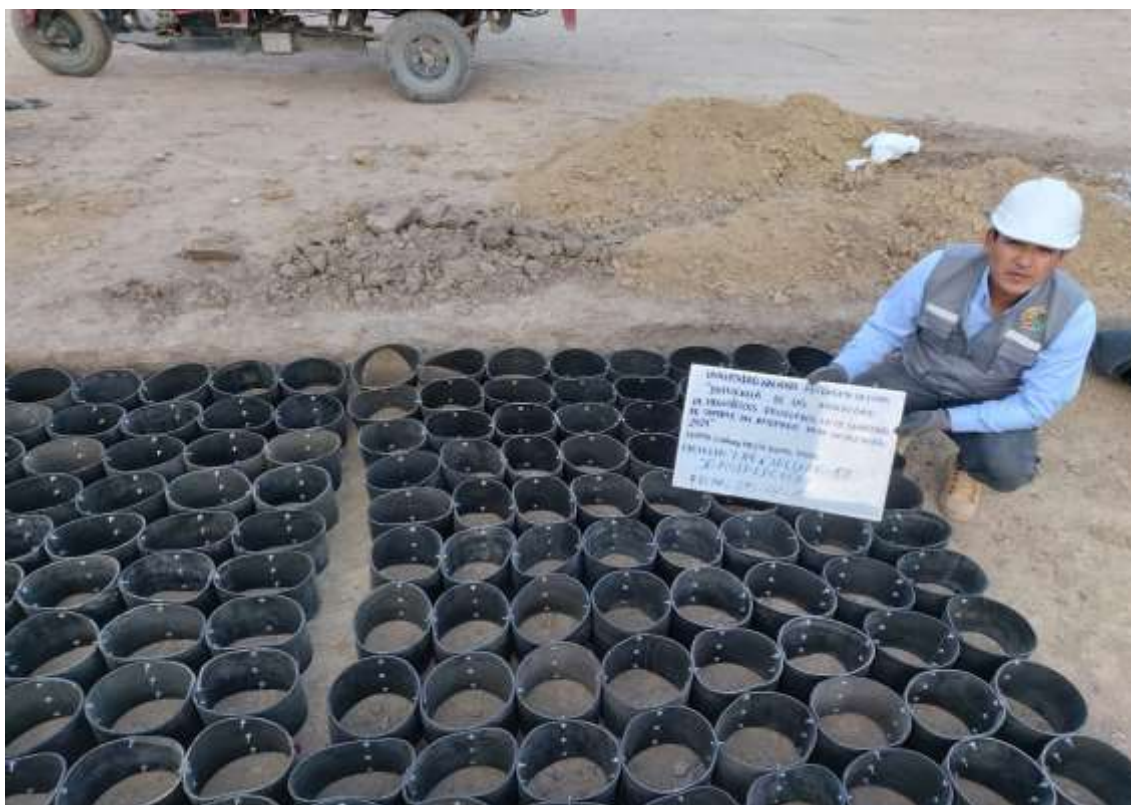
Fotografía 87. Instalación de geoceldas circulares
