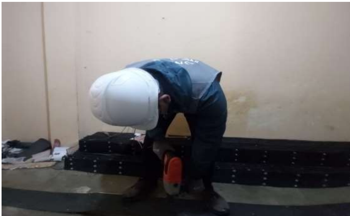
Fotografía 73. Confección de geoceldas romboidales
