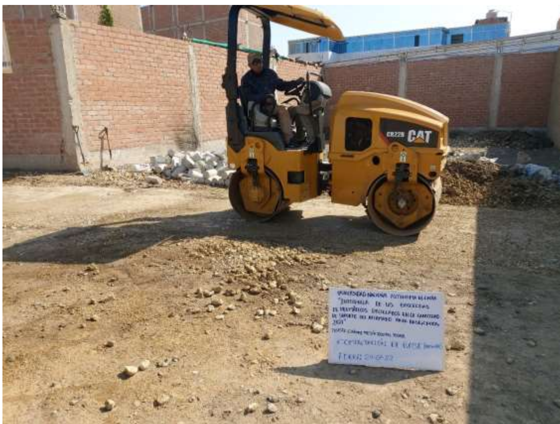
Fotografía 107. Compactación de la base con rodillo vibratorio
