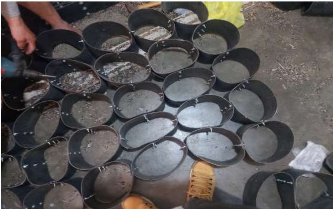
Fotografía 71. Confección de geoceldas
