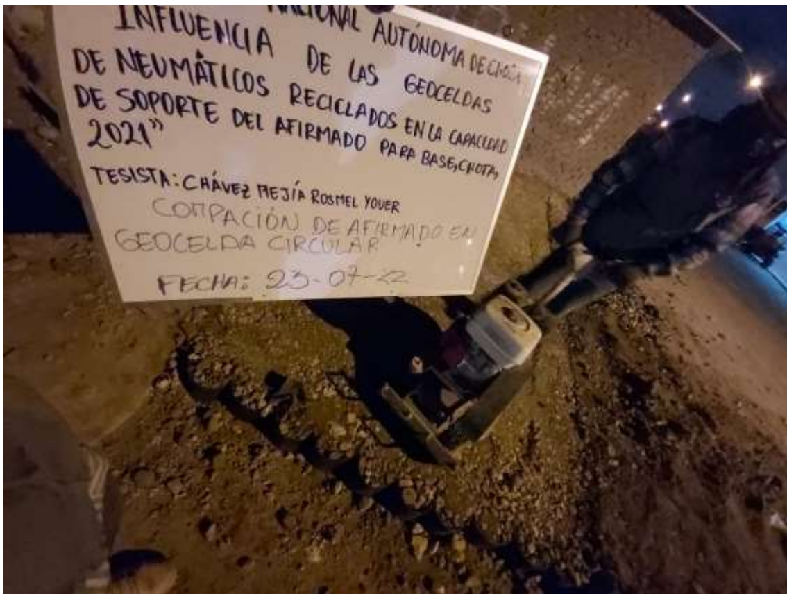
Fotografía 103. Compactación de la base con geoceladas circulares
