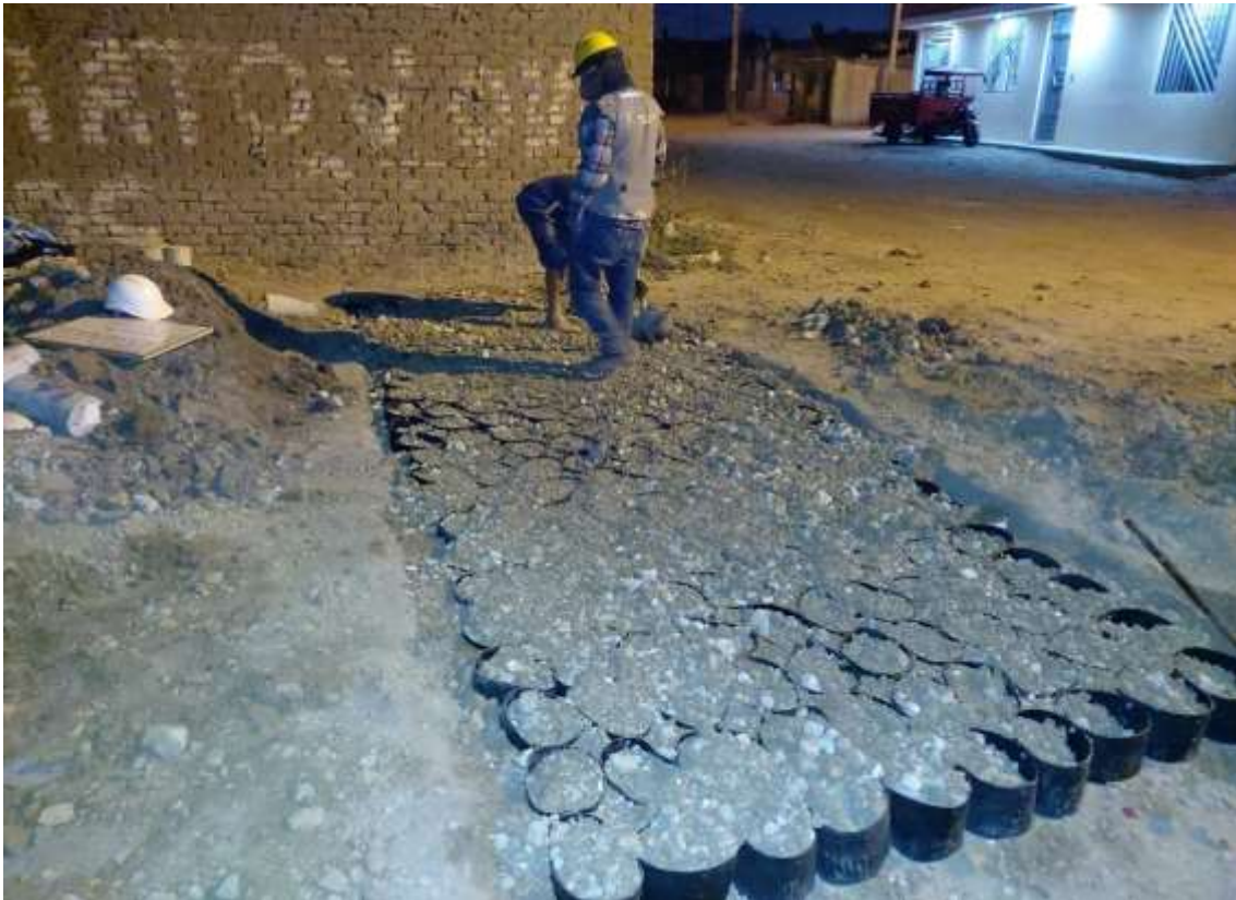
Fotografía 101. Colocación de afirmado en las geoceldas circulares
