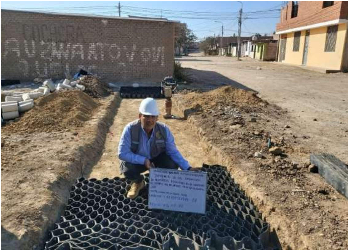
Fotografía 91. Instalación de geoceldas romboidales
