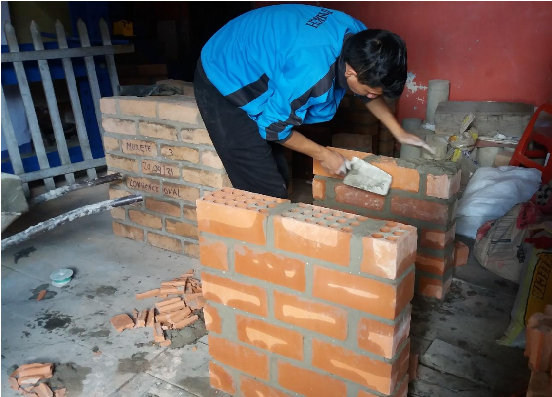
Fotografía 17. Elaboración de muretes de albañilería
