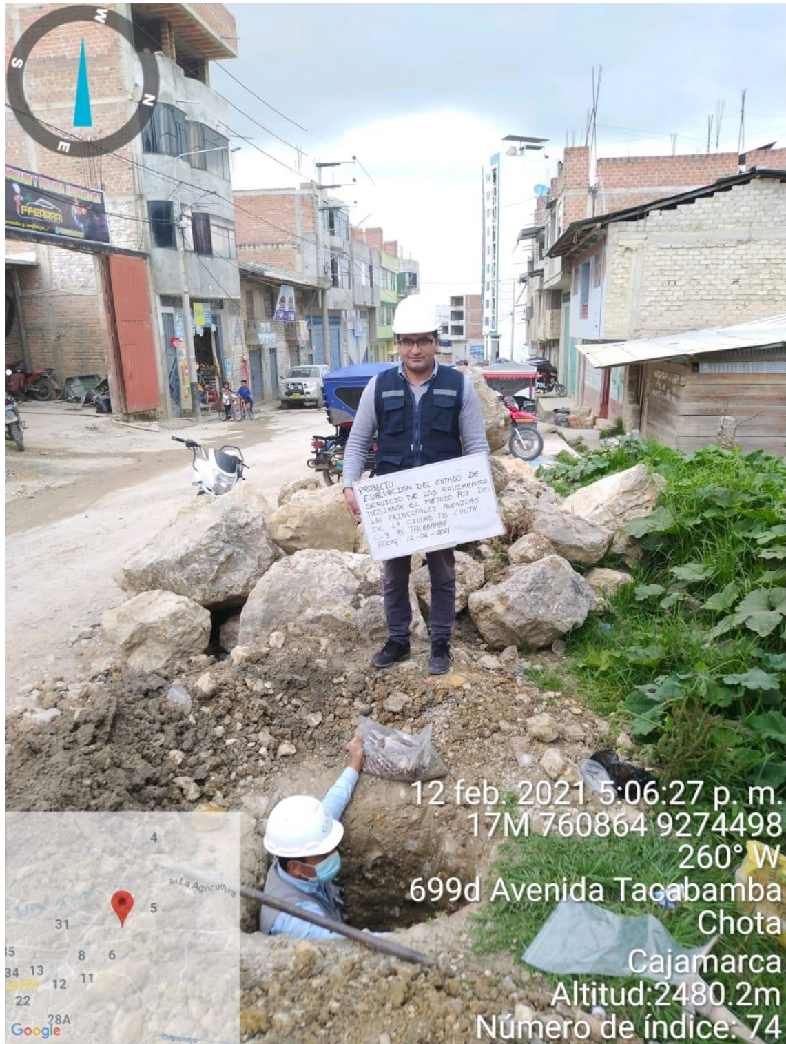
Fotografía 11. Calicata 3, Avenida Tacabamba
