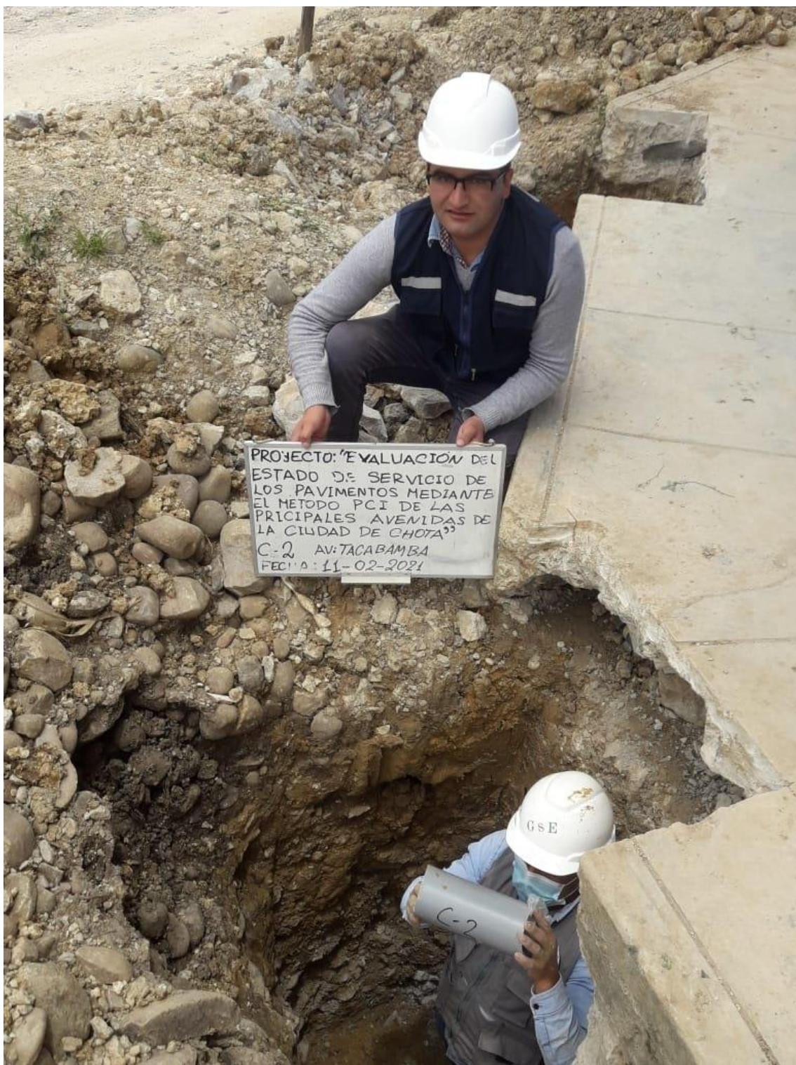
Fotografía 10. Calicata 2, Av. Tacabamba
