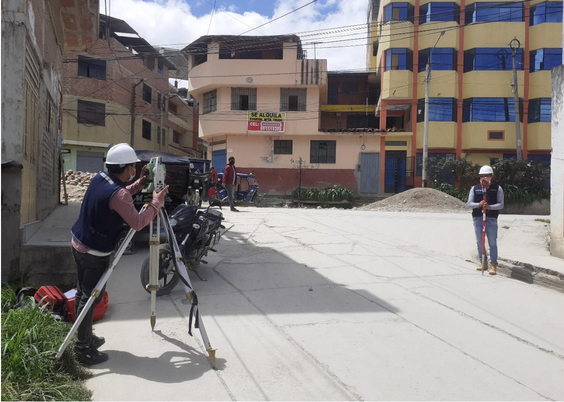
Fotografía 2. Levantamiento topográfico, Avenida Tacabamba
